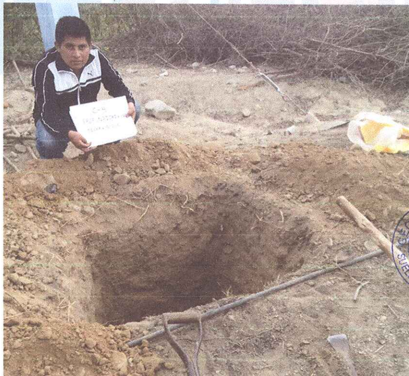
Foto N° 04.- Se aprecia en detalle una vista panorámica de la calicata C-04
