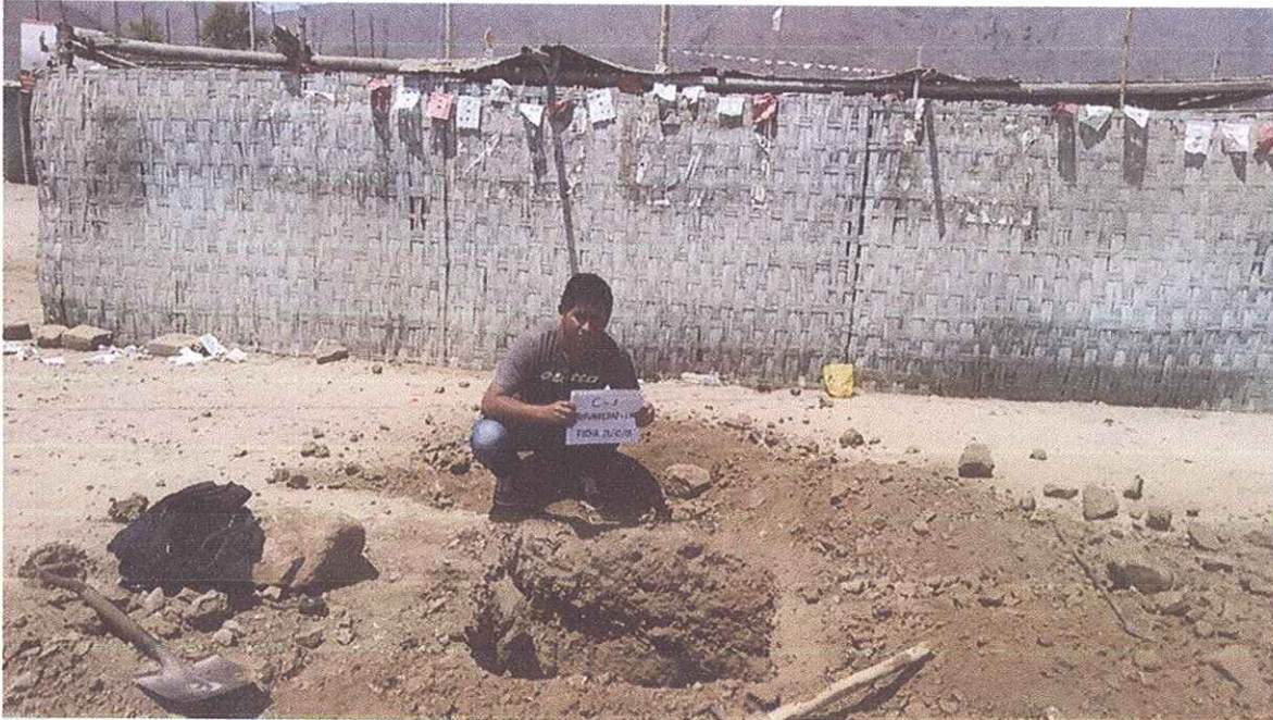
Foto N° 01.- En la toma se aprecia una vista panorámica del lugar donde se excavo la Calicata C-01.
