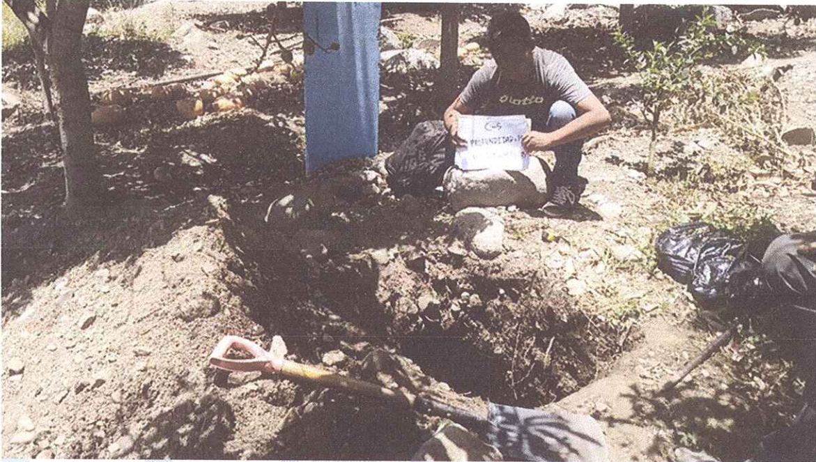
Foto N° 05.- Se aprecia una vista general del lugar donde se excavo la calicata C-05.
