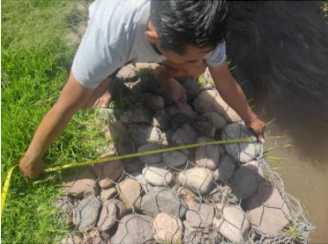
Fotografía 3: Midiendo el ancho del gavión existente
