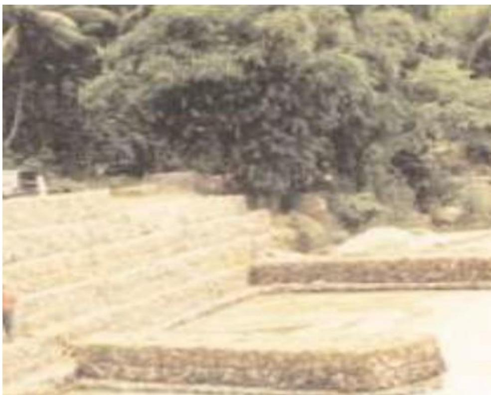
***Figura N°3. Obra deflectora (Espigón).***
