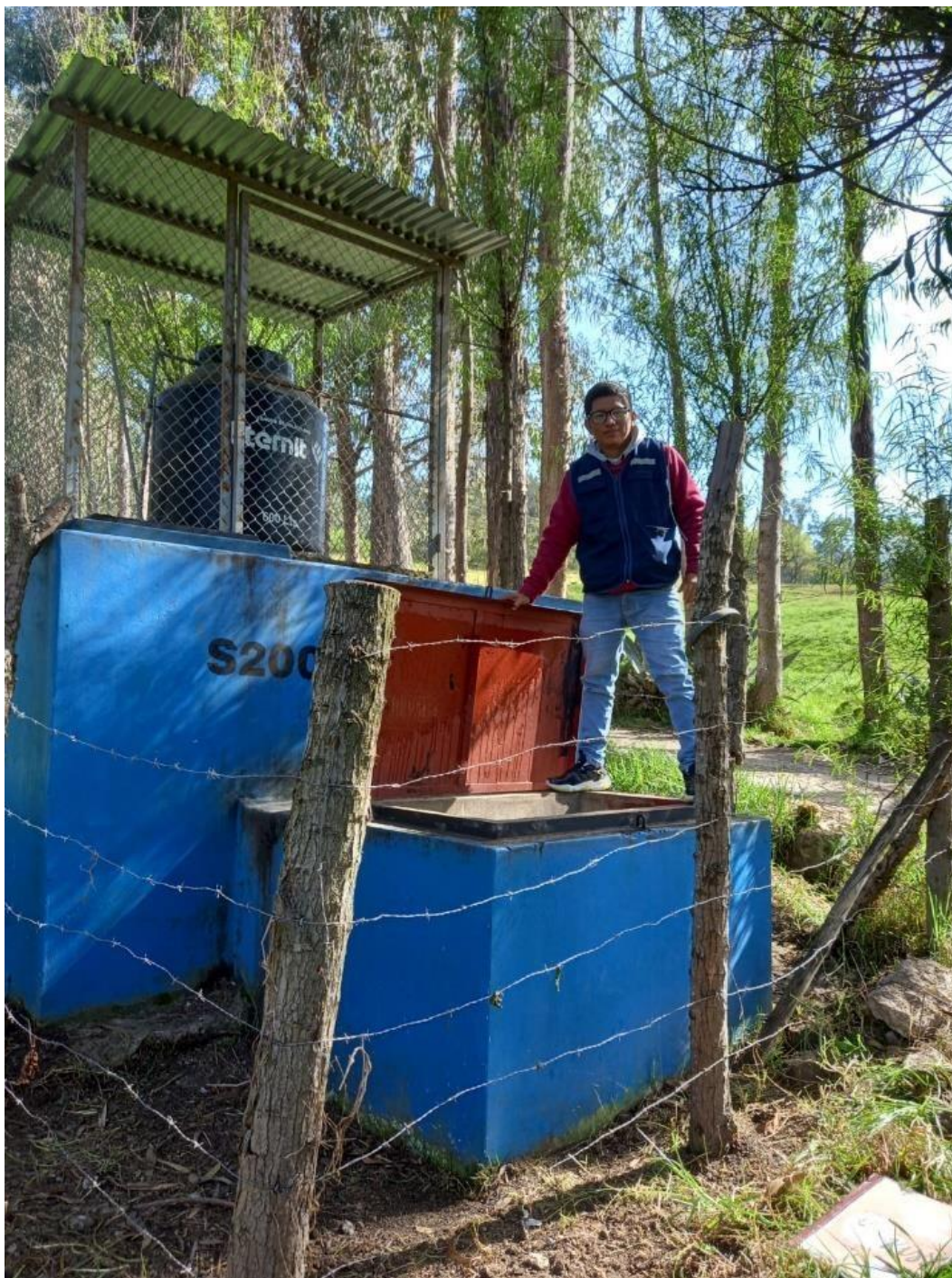
Figura 13: realización de la evaluación del sistema de abastecimiento de agua potable del caserío cajas de alumbre
