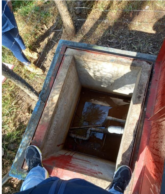
Figura 15: evaluación de la casetas de valvulas del reservorio
