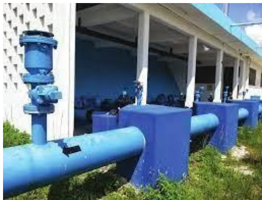
Figura N° 13. Conducción por bombeo
