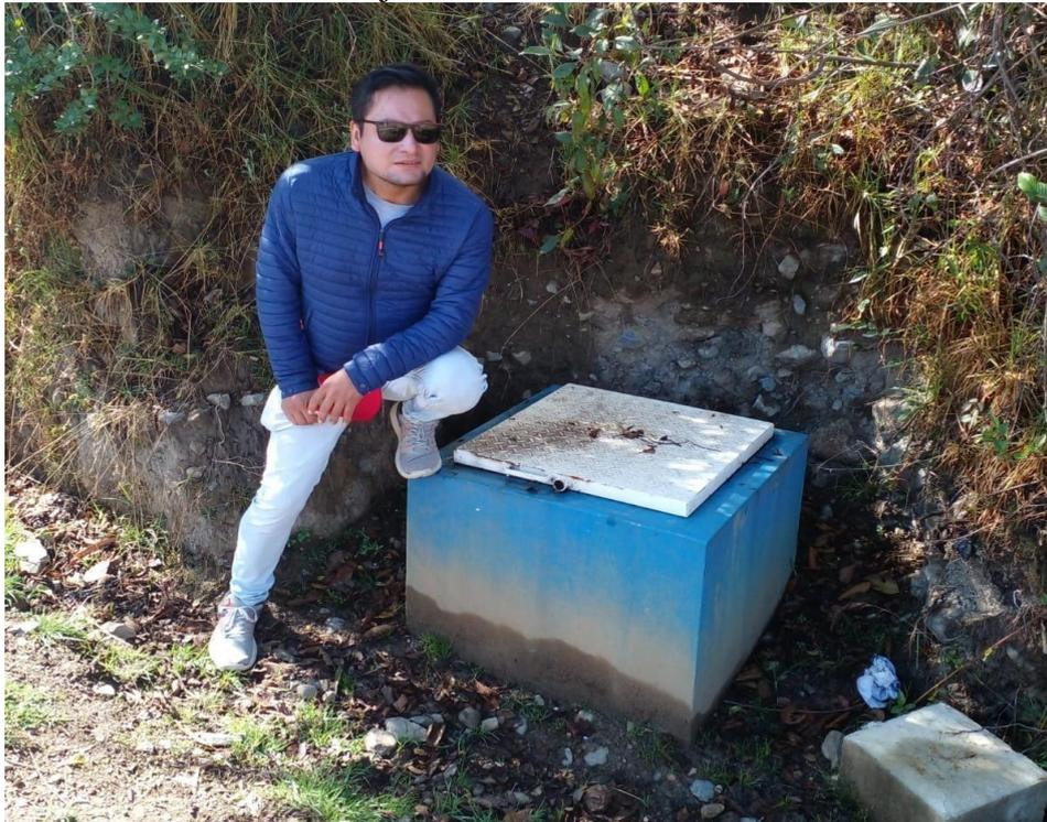
Caja de válvulas sin mantenimiento
