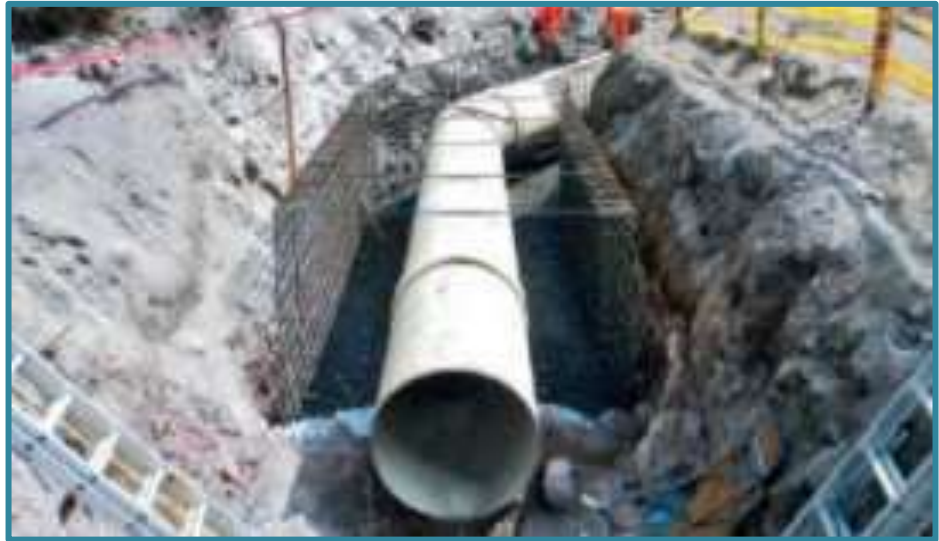
Figura 12. Tubería de la línea de conducción
