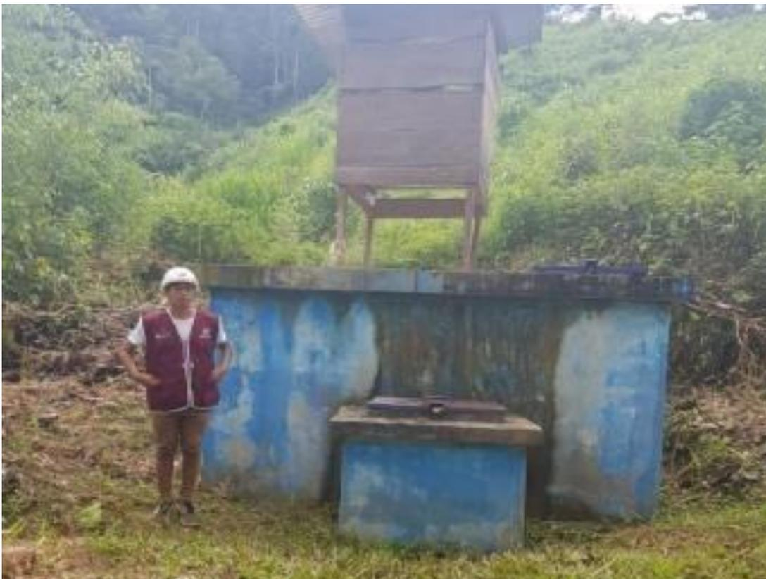
Figura 5:reservorio del sistema de abastecimiento de agua potable
