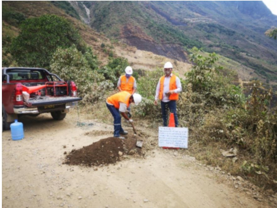
Imagen 5: Realizando calicatas para EMS.
