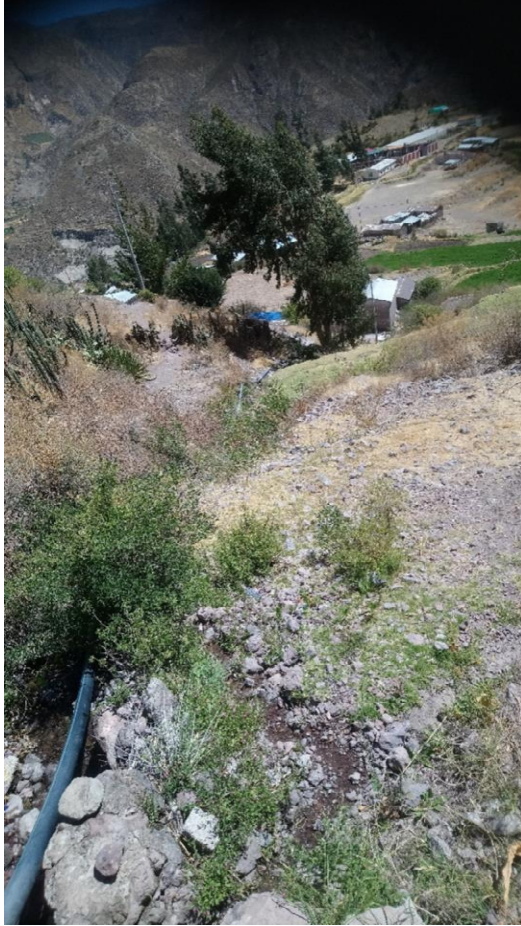
9.- TUBERIA DE LA LINEA DE ADUCCION SOBRE EL TERRENO NATURAL.
