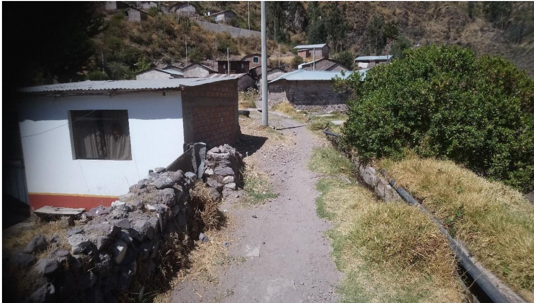
11.- TUBERIA DE LA LINEA DE ADUCCION SOBRE EL TERRENO NATURAL.
