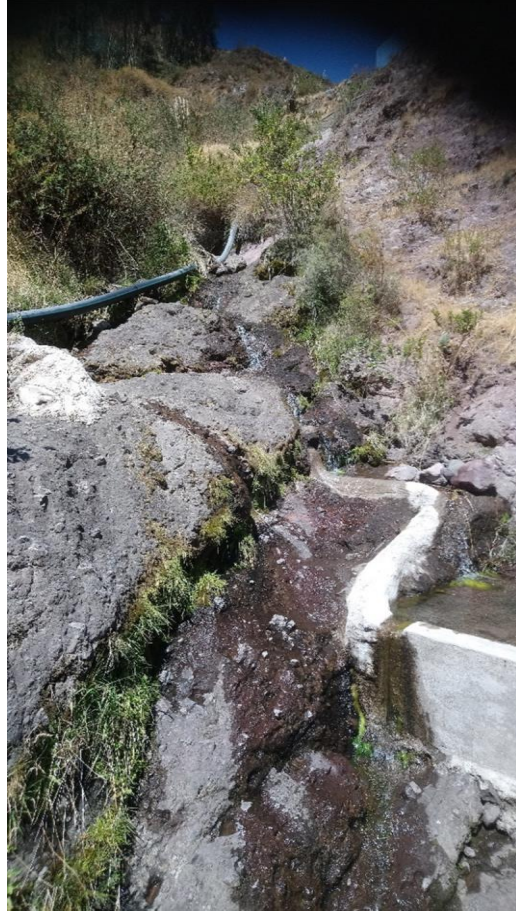
9.- TUBERIA DE LA LINEA DE ADUCCION SOBRE EL TERRENO NATURAL.
