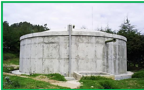
Figura: Fotografía de reservorio apoyado
