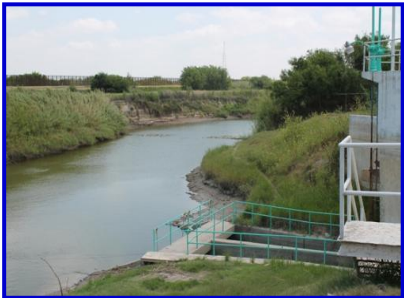
Figura 3: Captación una fuente superficial (río).
