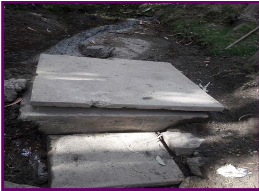
Figura 26: Captación actual del caserío de Jaihua sin cerco perimétrico de protección y en malas condiciones partes de la estructura
