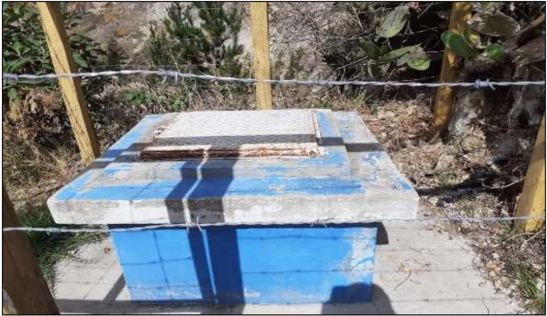
Fotografía 03: Cámara de rompe presión CRP-6
