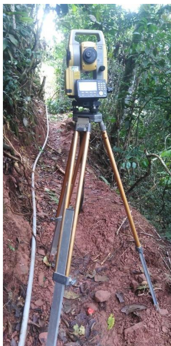
FOTO N°04: Vista de levantamiento topográfico en la línea de conducción del sistema de agua potable de la comunidad nativa de santa clara
