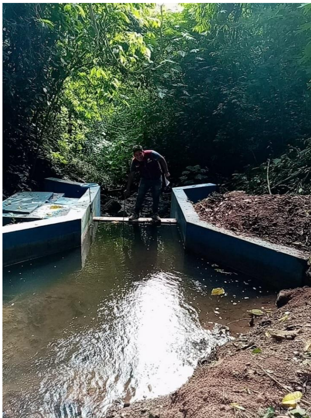
FOTO N°03: Vista de Captación barrage de toma lateral
