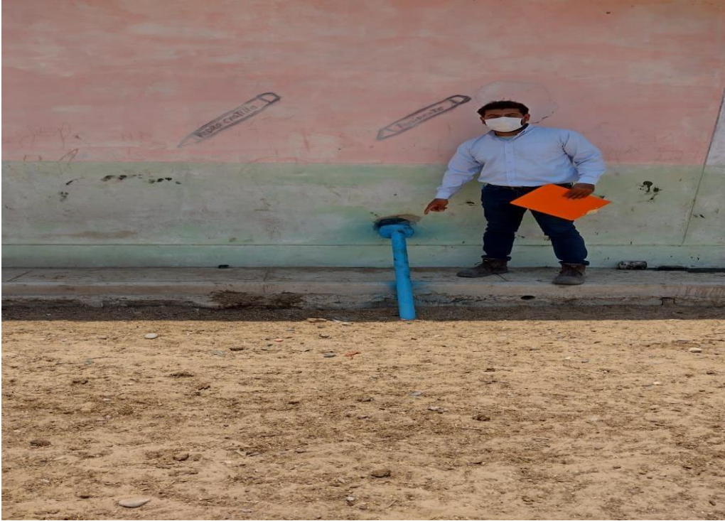
Figura N° 3: vista de la tubería de impulsión
