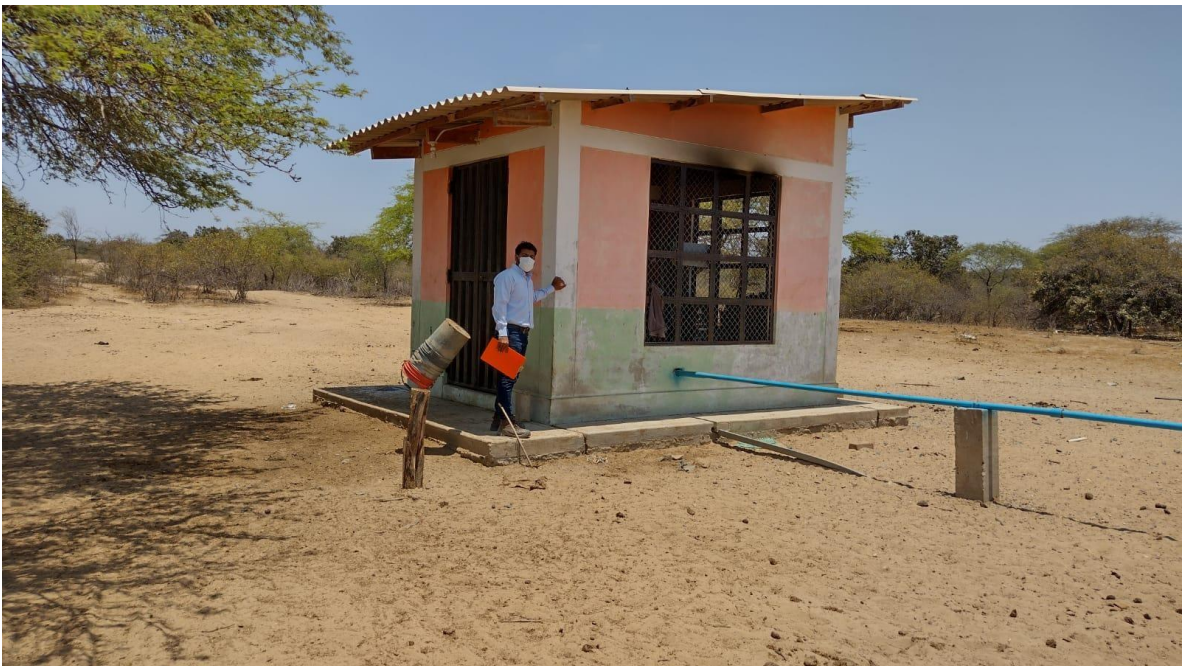
Figura N° 4: Caseta de Bombeo de agua
