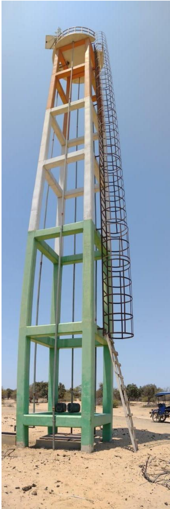
Figura N° 7: Reservorio apoyado de polietileno de 5 m 3
