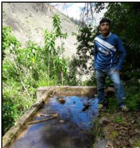
Foto 02: Vista de la cámara húmeda de la captación del centro poblado de Quillabamba.
