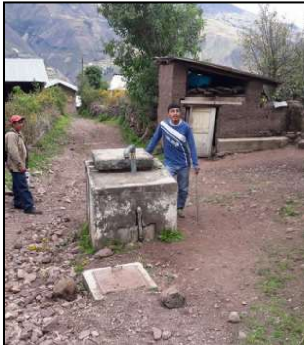
Foto 06: Estado de una de las cámaras rompe-presión de la línea de aducción del centro poblado de Quillabamba.
