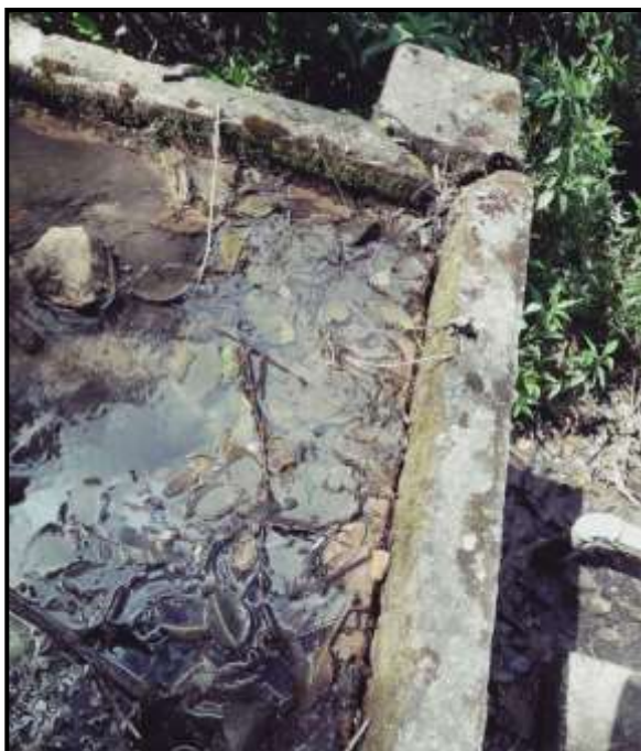
Foto 03: Estado de la cámara húmeda de la captación del centro poblado de Quillabamba.
