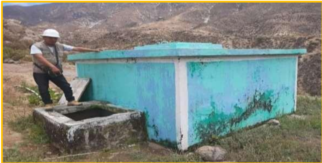
Imagen 3: Reservorio del caserío de Pocso.
