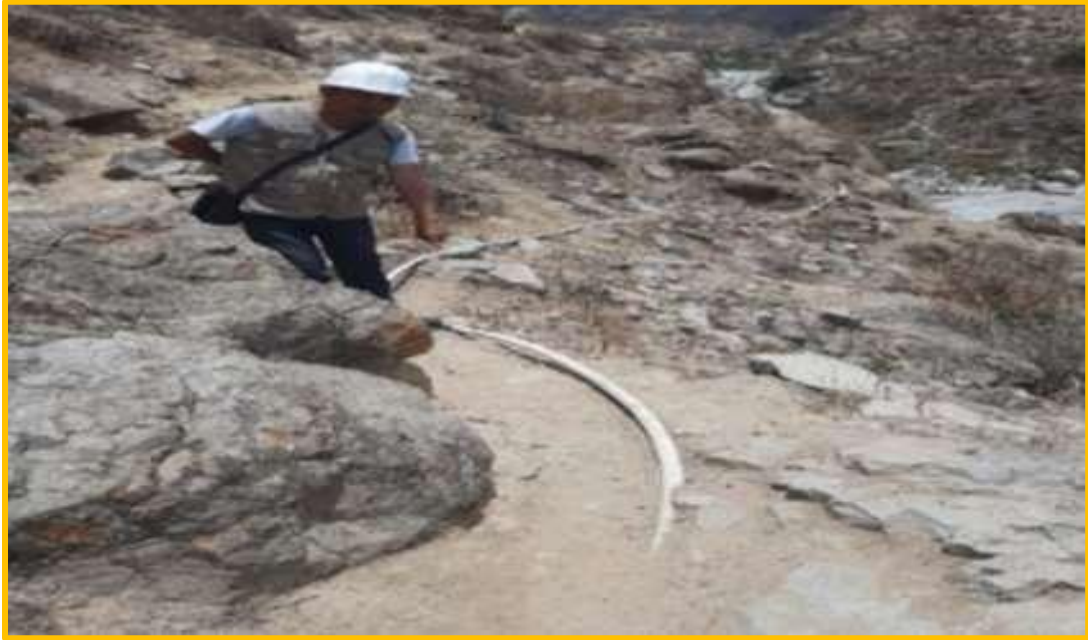
Imagen 4: Línea de aducción del caserío de Pocso.
