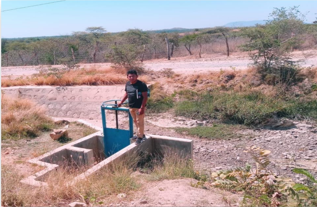
Imagen 1: Captación de agua superficial (Canal).
