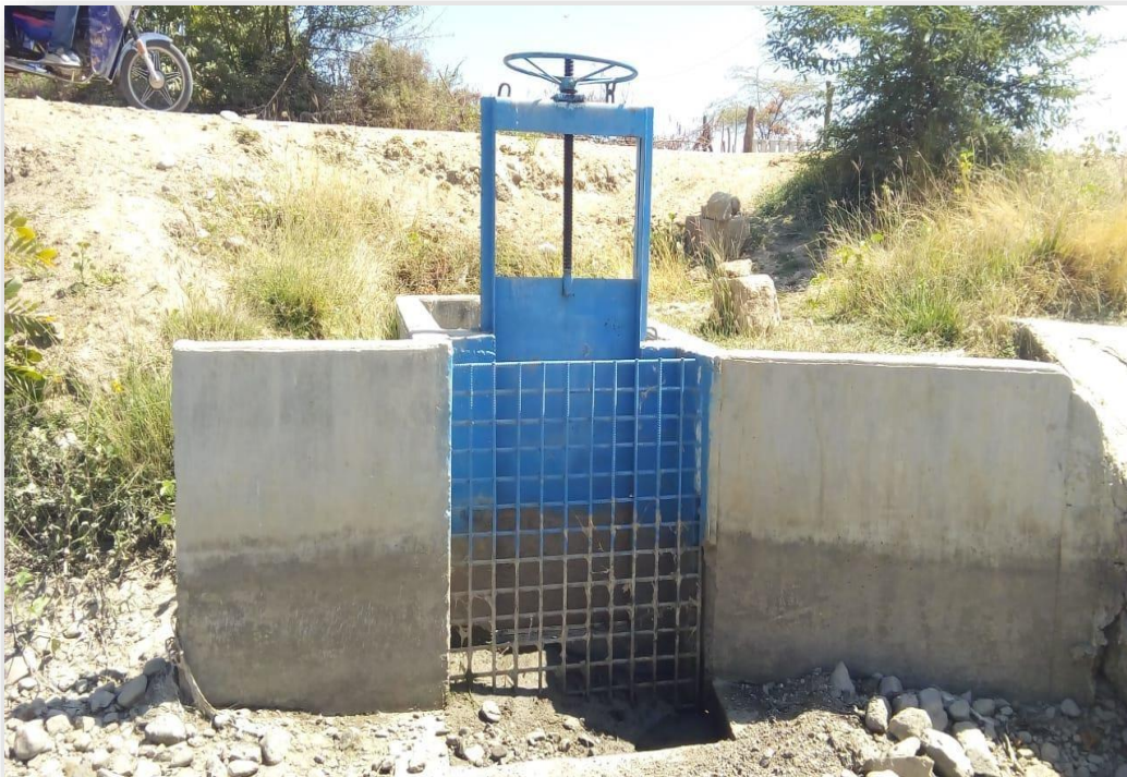
Imagen 1: Captación de agua superficial (Canal).
