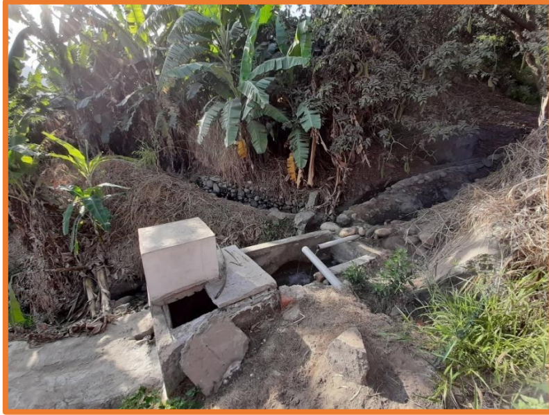
Imagen 5. Vista panorámica de la captación “puquial del 24” del caserío Kilómetro 24 Pampa de Vinzos.
