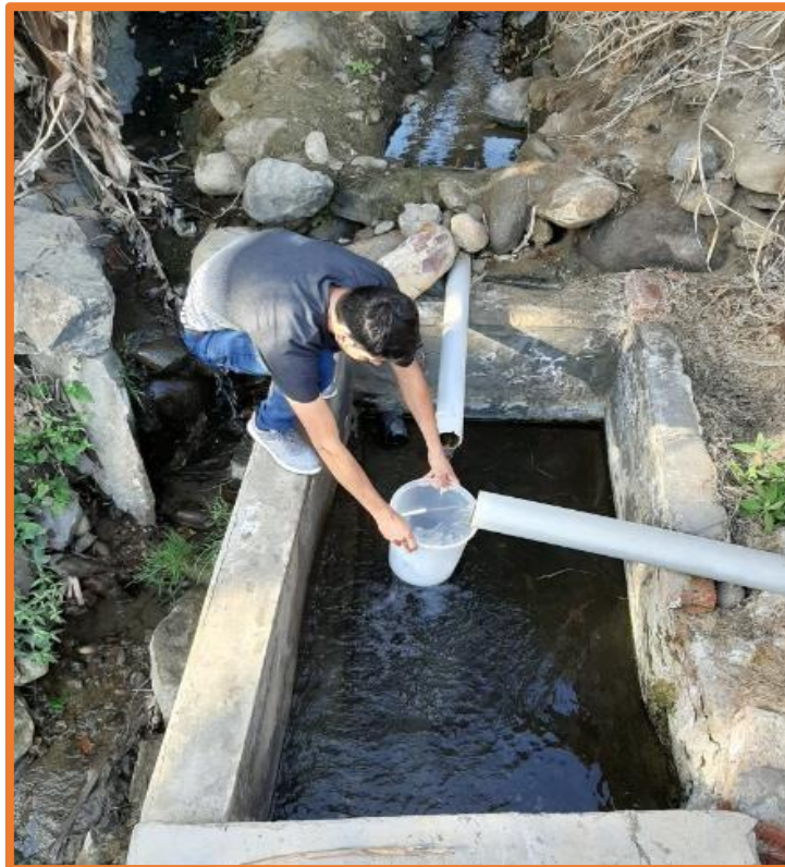
Imagen 6. Medición del caudal mediante el método volumétrico de la captación del manantial de ladera y concentrado en un balde de 10 lt.
