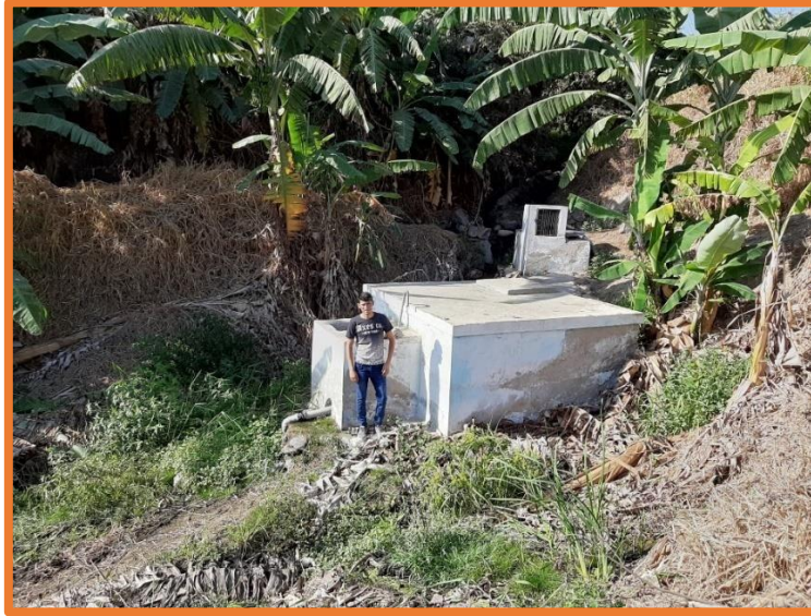
Imagen 9. Vista panorámica del reservorio existente del caserío Kilómetro 24 Pampa de Vinzos.
