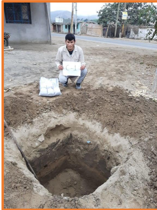
Imagen 17. Calicata N° 01, en el caserío Kilómetro 24 Pampa de Vinzos a 124.40 m.s.n.m.
