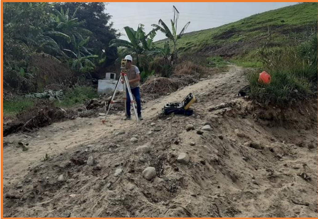
Imagen 15. Realizando el levantamiento topográfico de la línea de aducción con estación total.
