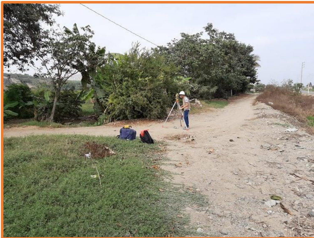
Imagen 16. Realizando el levantamiento topográfico de la Red de distribución con estación total.
