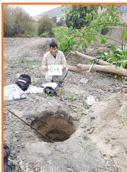
Imagen 20. Calicata N° 04, en la línea de aducción a 130.60 m.s.n.m.
