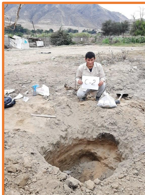
Imagen 18. Calicata N° 02, en el caserío Kilómetro 24 Pampa de Vinzos a 125.22 m.s.n.m.
