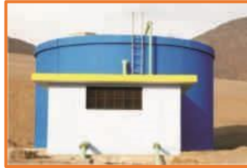
Figura 26. Reservorio apoyado circular.
