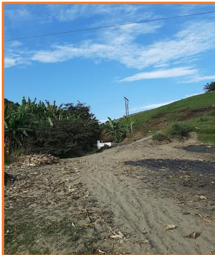
Imagen 10. Vista panorámica del primer tramo de la línea de aducción existente del caserío Kilómetro 24 Pampa de Vinzos.
