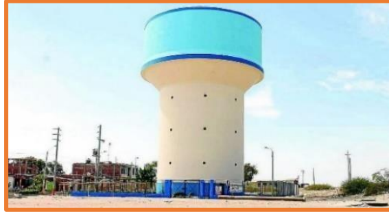
Figura 25. Reservorio elevado circular.
