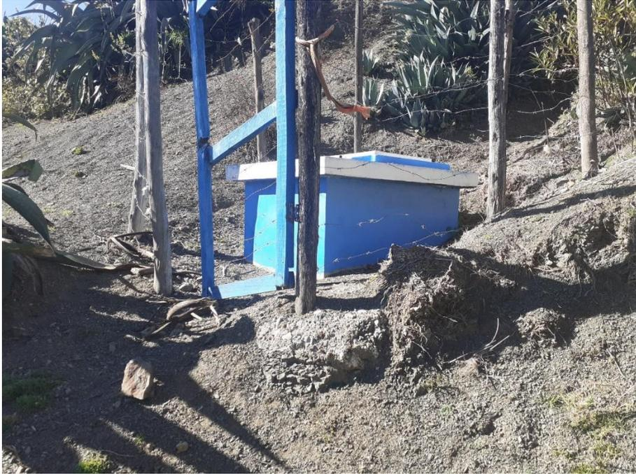
**Fotografía N° 7.** Cámara de rompe presión, distribución y purga – Nawinpuquio.
