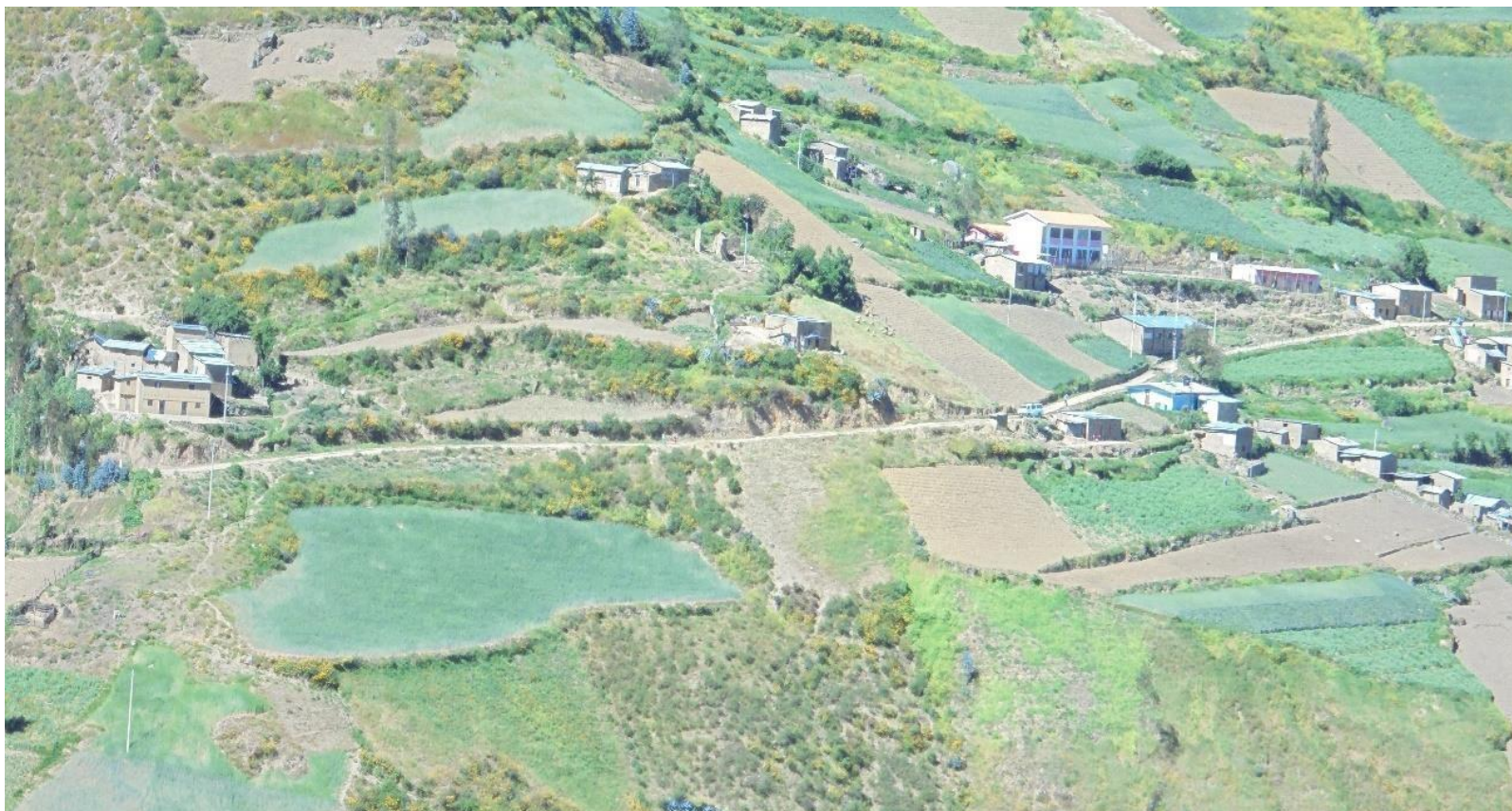
Imagen 01: Vista panorámica del Caserío de Chunya, centro poblado de Chclancayo, Distrito de Pamparomás, Provincia de Huaylas, Departamento de Áncash.
