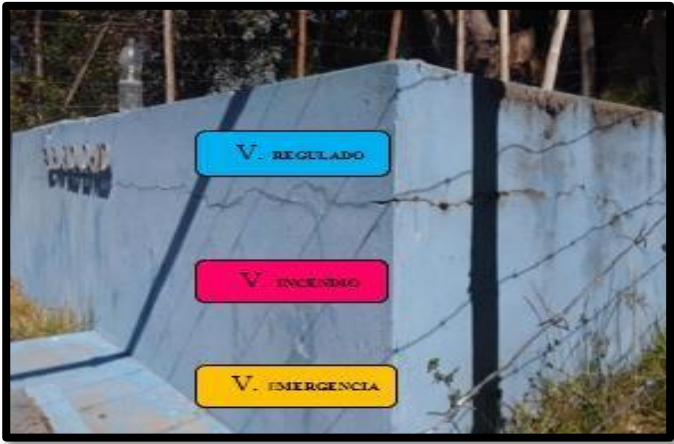
Figura 5. Reservorio. Fuente: Elaboración propia.
