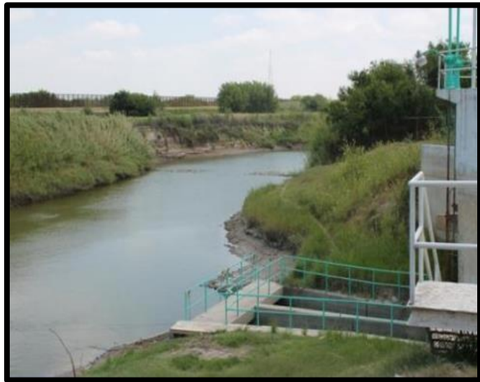
Figura 6: Captación una fuente superficial (río).
