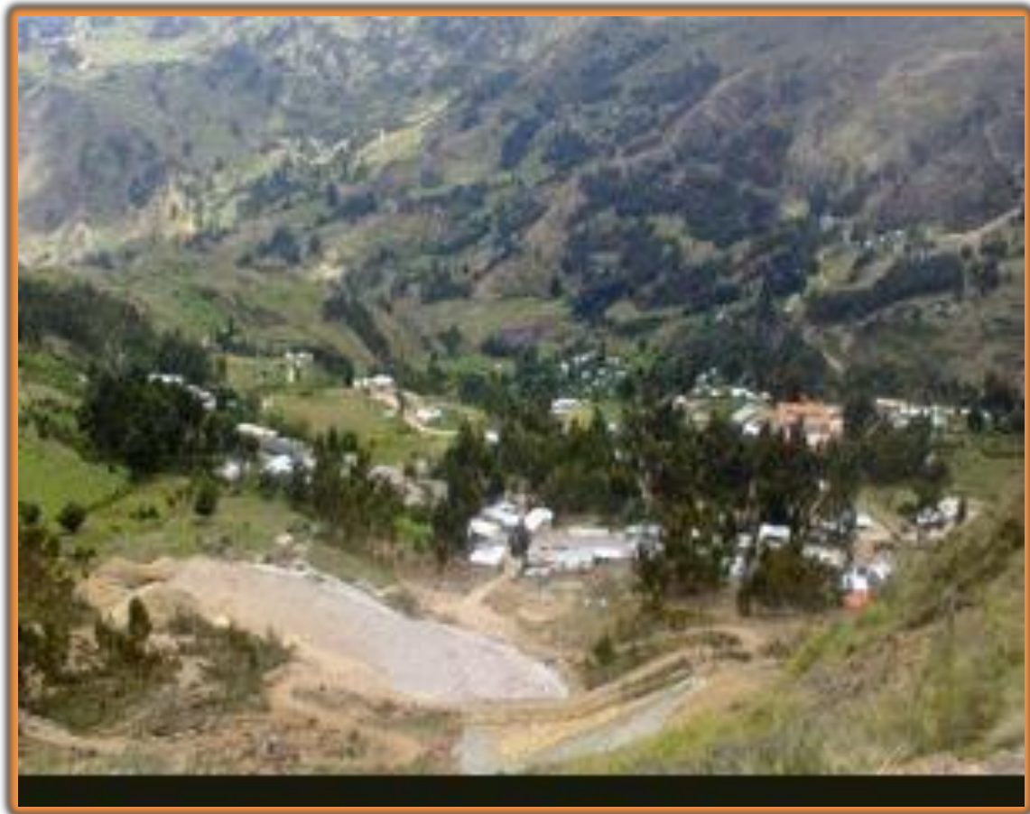
Figura 18: Línea de aducción del caserío de Ichon..
