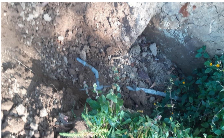
Imagen 05: Tubería de la línea de conducción
