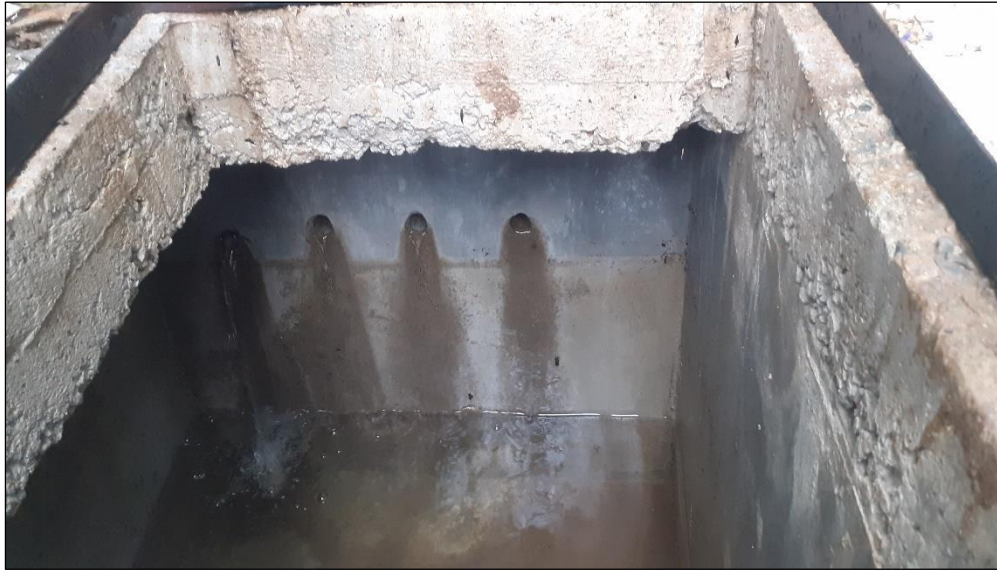
Imagen 02: Cámara húmeda de la captación
