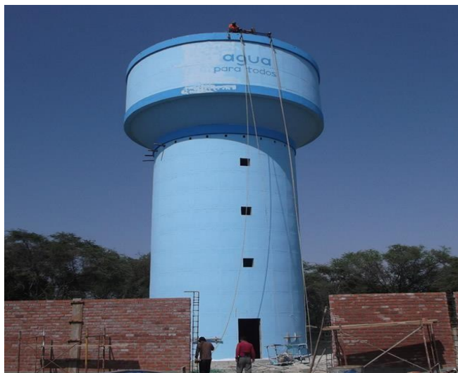
Figura 7: construcción de tanque elevado
