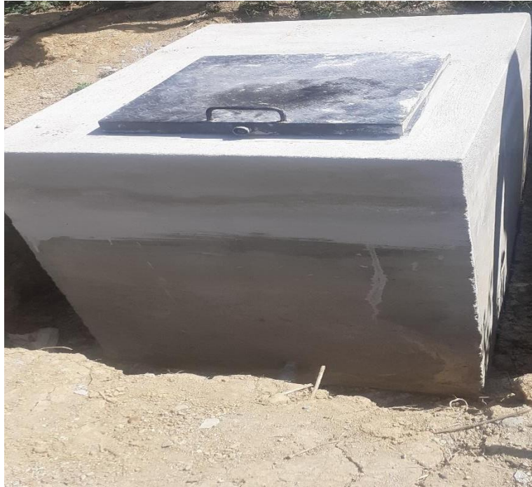
Imagen 09: Cámara rompe presión tipo 7
