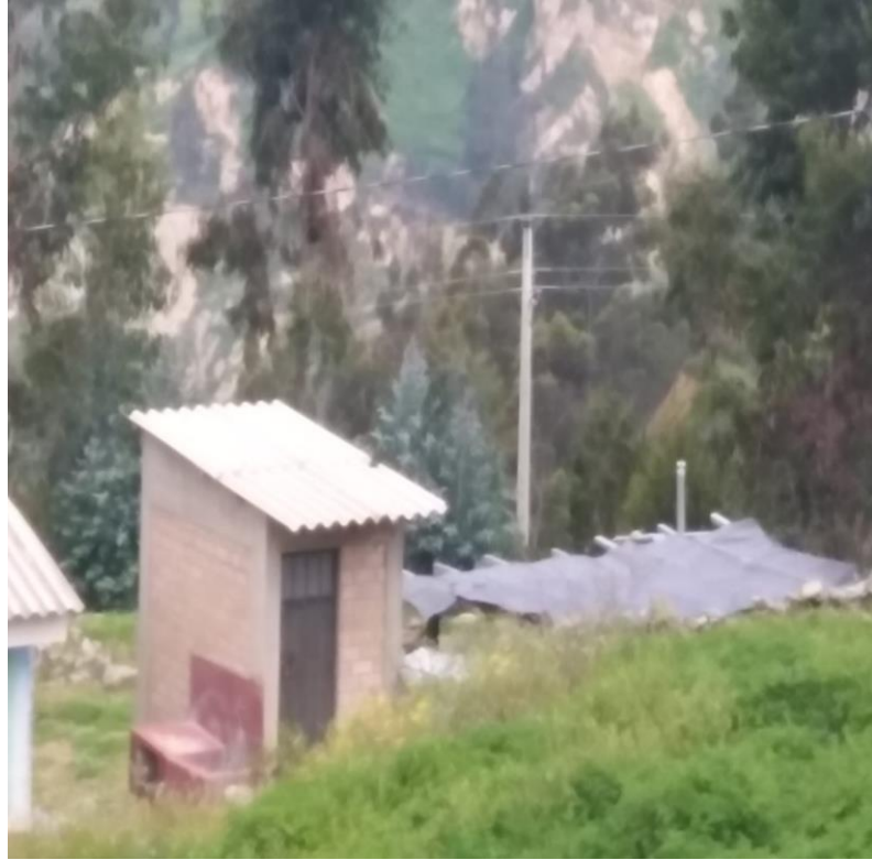
Fotografía 23: Conexiones domiciliarias (caseta de albañilería)
