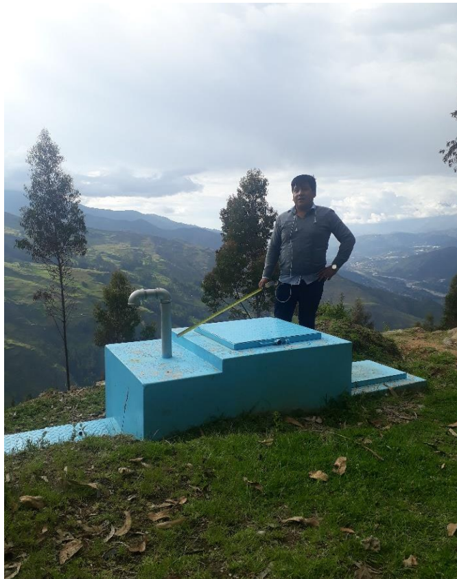
Fotografía 14. Cámara de distribución de caudal
