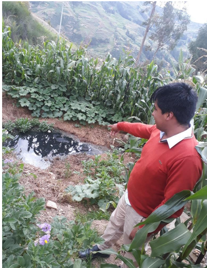
Fotografía 26: Pozo de filtro colmatado, emanando malos olores
