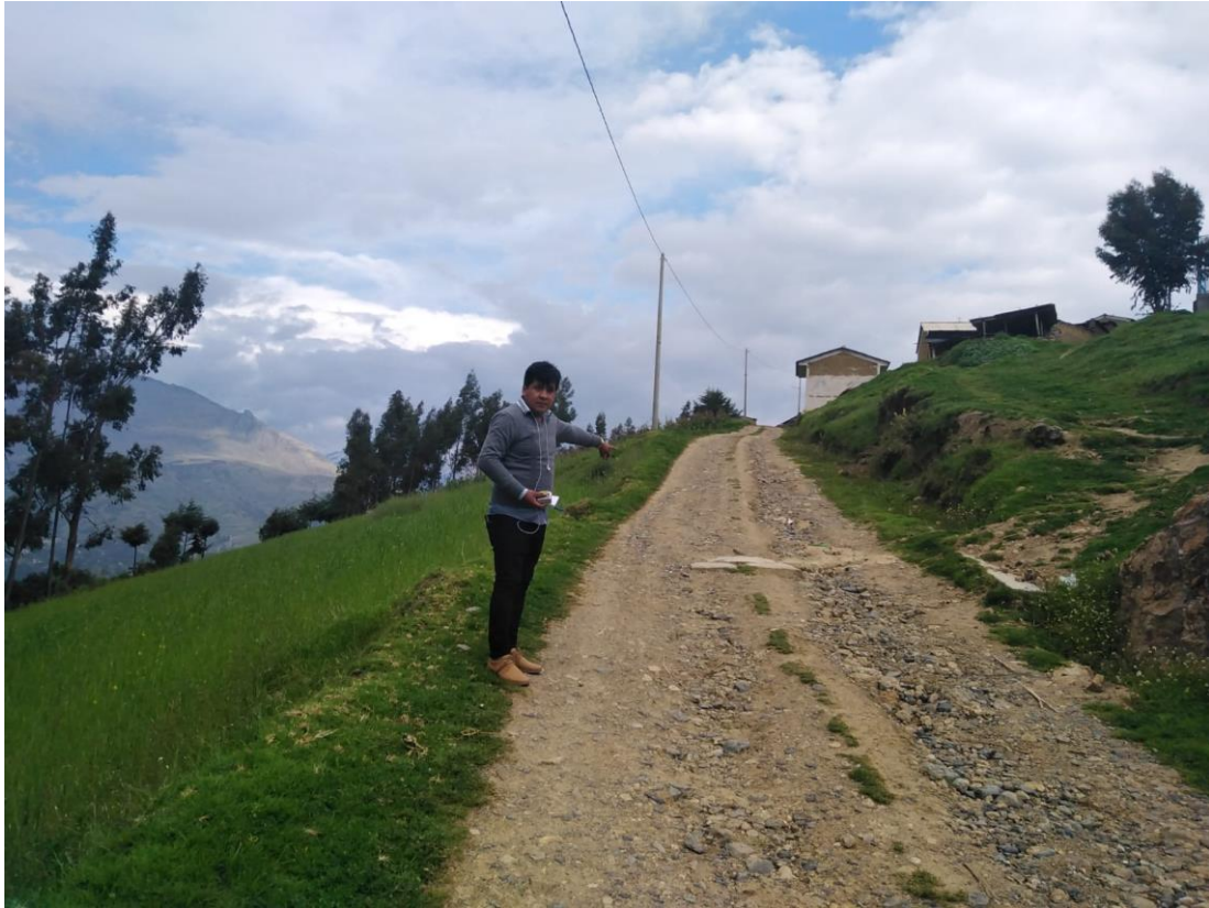
Fotografía 19. Red de distribución de agua potable
