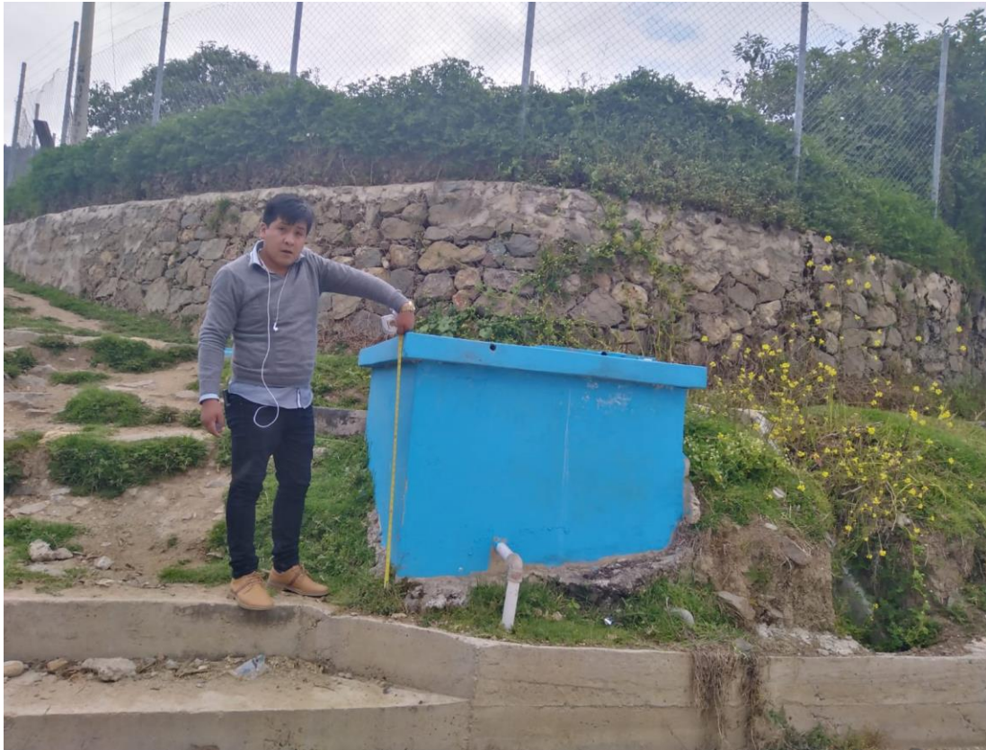
Fotografía 13. Diagnóstico de cámara de rompe presión Tipo 7 – CRP 7
