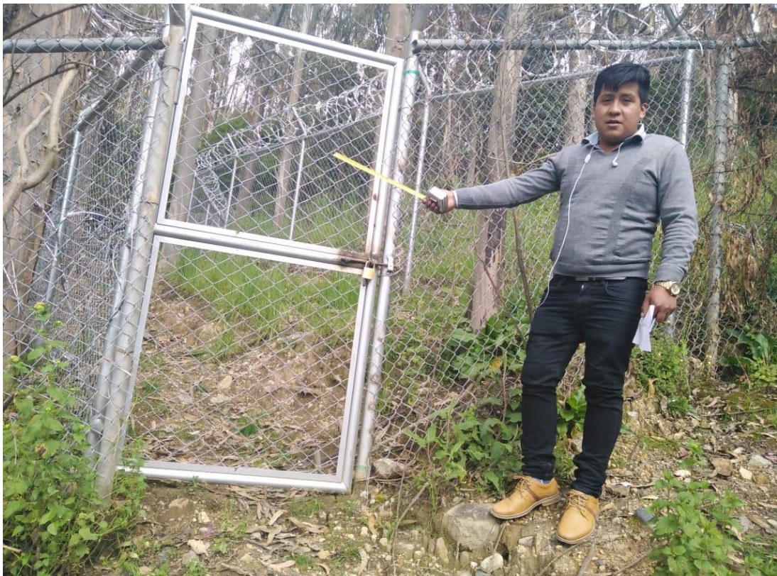
Fotografía 02. Cerco perimétrico de primera captación de agua
