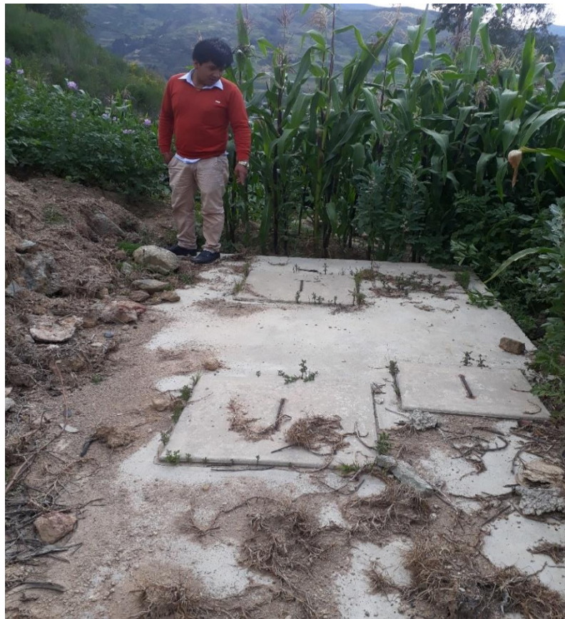
Fotografía 24: Diagnostico de tanque séptico
