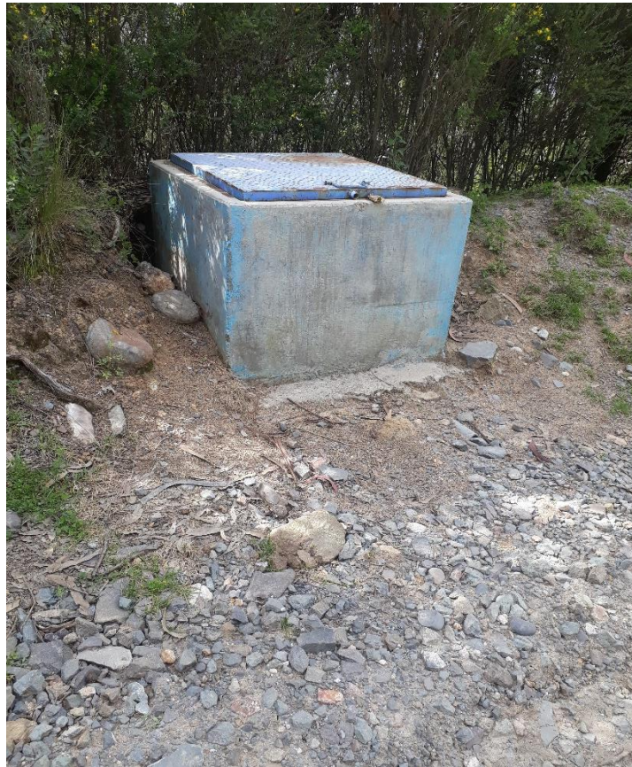
Fotografía 17. Tercera cámara de reunión de caudal
