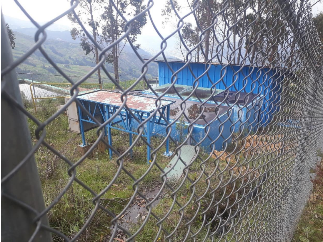
Fotografía 09. Planta de tratamiento de agua potable – PTAP
