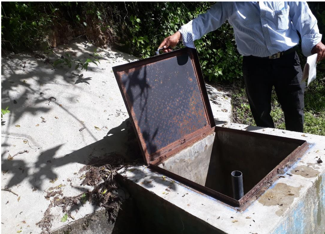
Fotografía 06. Presidente de junta directiva inspeccionando la captación
