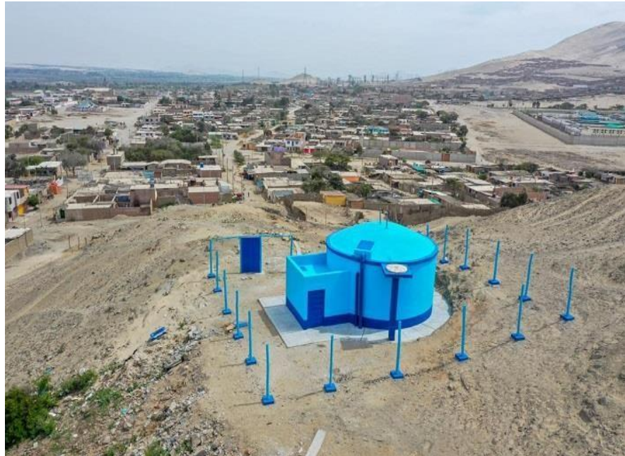
Figura 08. Reservorio de almacenamiento de agua potable
