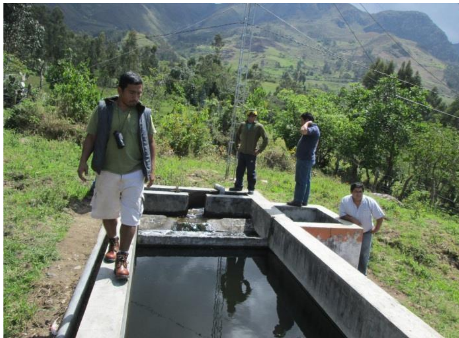
FUENTE: Elaboración propia. Sedimentador; primera unidad de pre-tratamiento del agua cruda, a donde llega la línea de conducción de Ø3”.
