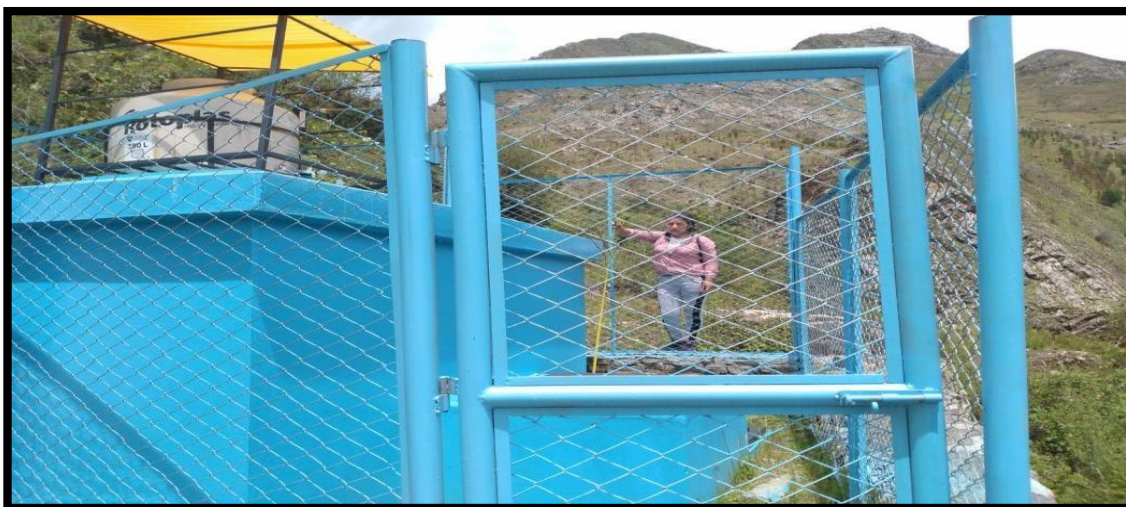
Fotografía 03: Reservorio de 10m3.
