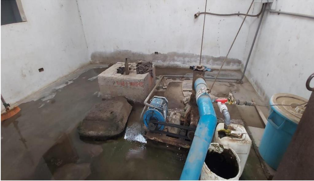
Fotografía 04: tubería de succión del pozo tubular
