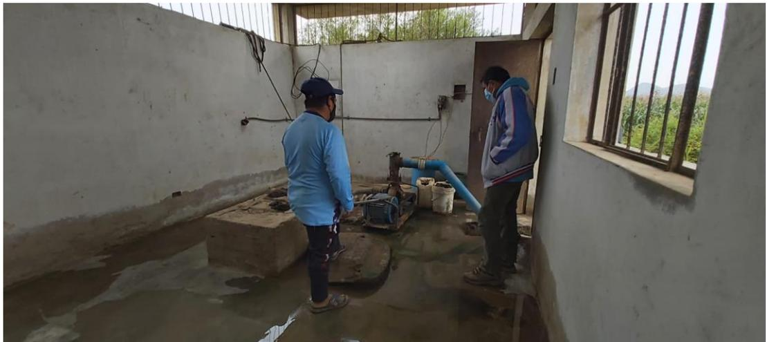
Fotografía 03: salida de la línea de impulsión diámetro 4"
