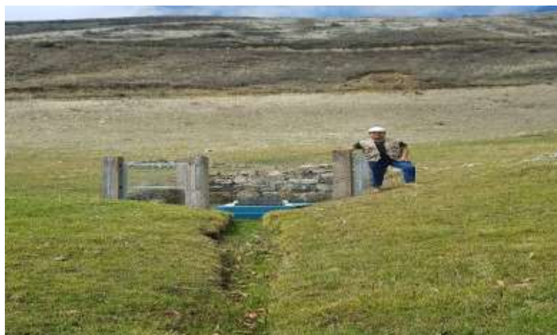
Imagen 13: se observa la captación de fondo del centro poblado Granero, distrito de Jesús, provincia de Cajamarca, departamento de Cajamarca.
