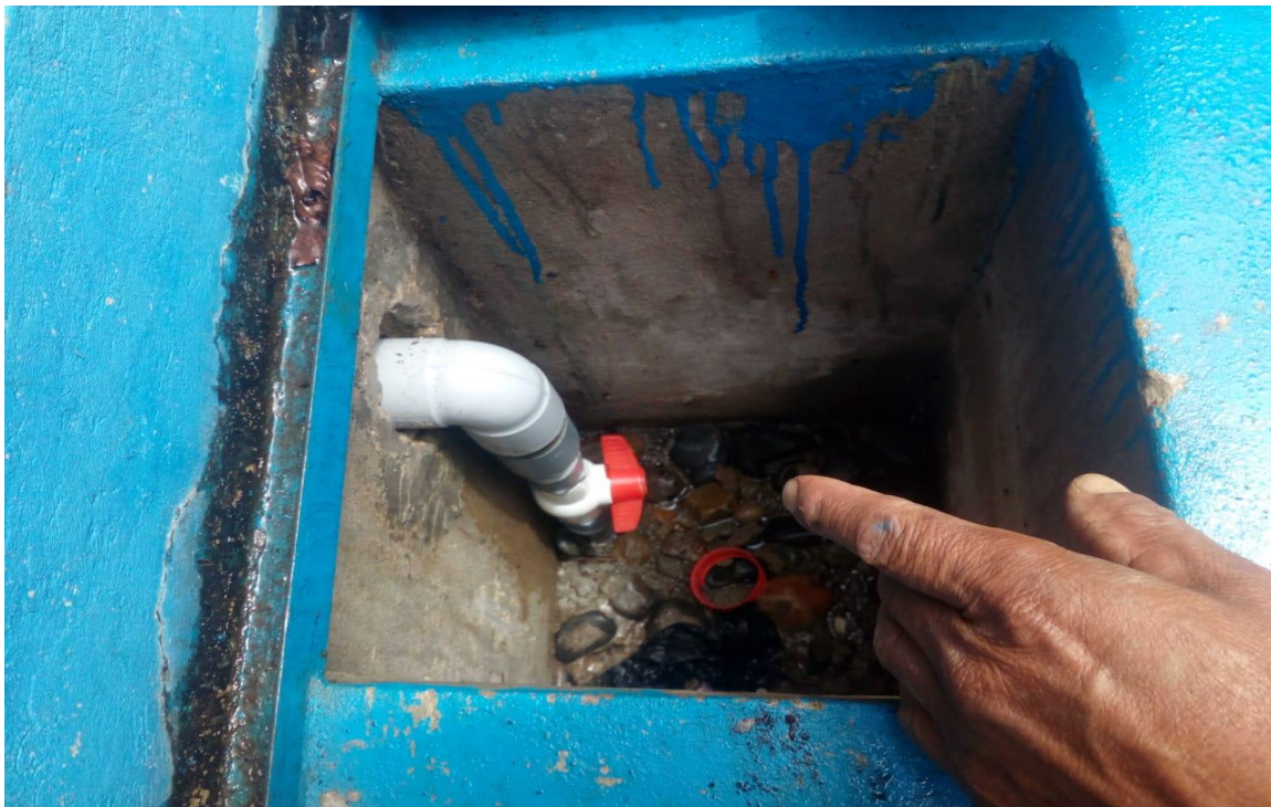
Figura 56. Visita de campo al sistema de saneamiento básico Fuente. Elaboración propia – 2020
