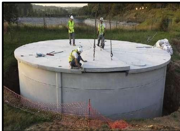
Figura 20. Ilustración de reservorio enterrado
