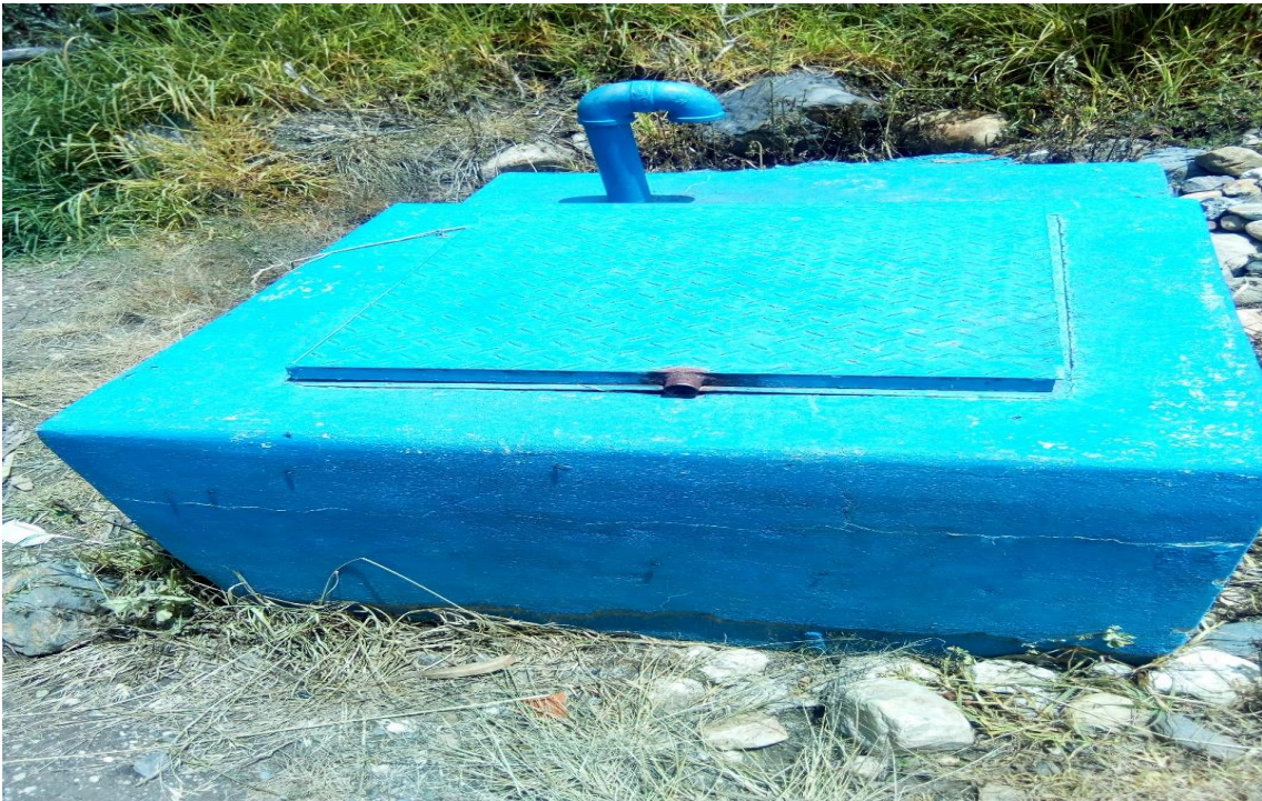
Figura 58. Visita de campo al sistema de saneamiento básico Fuente. Elaboración propia – 2020
