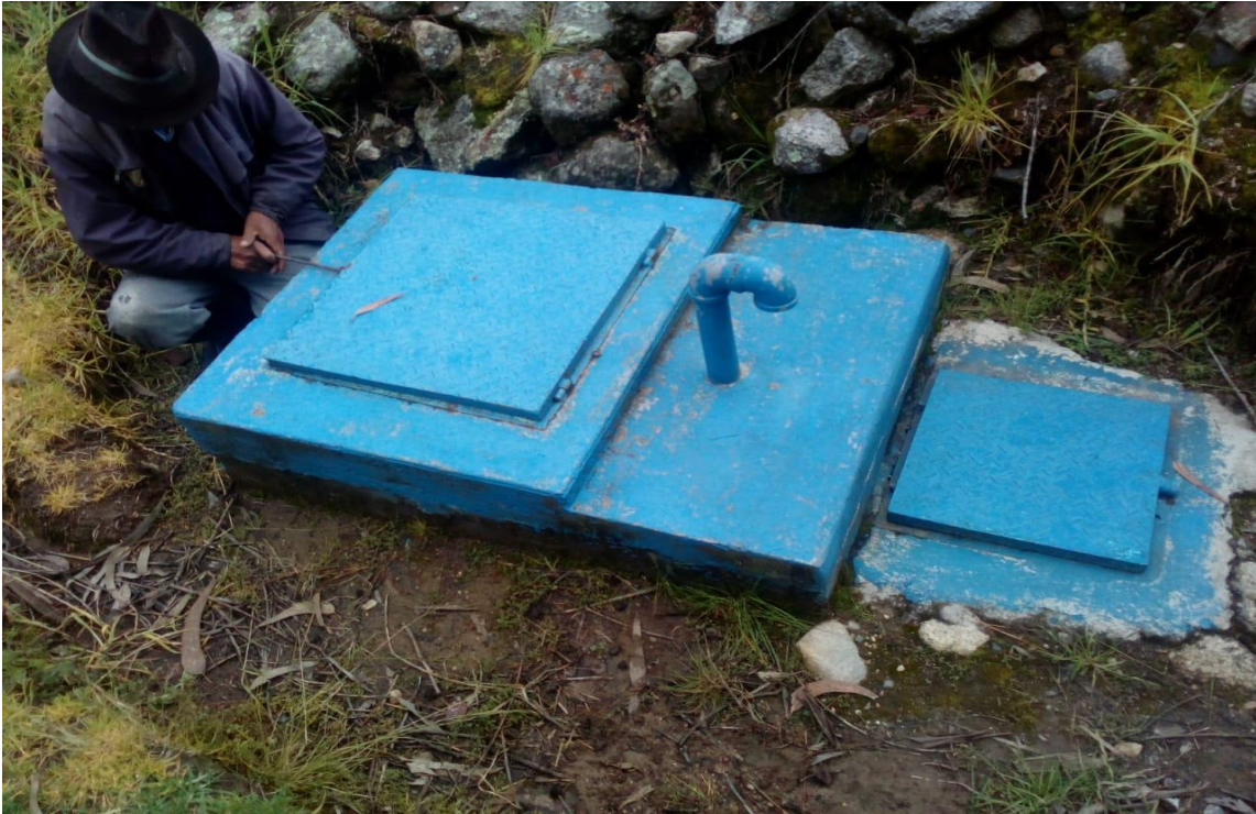
Figura 57. Visita de campo al sistema de saneamiento básico Fuente. Elaboración propia – 2020
