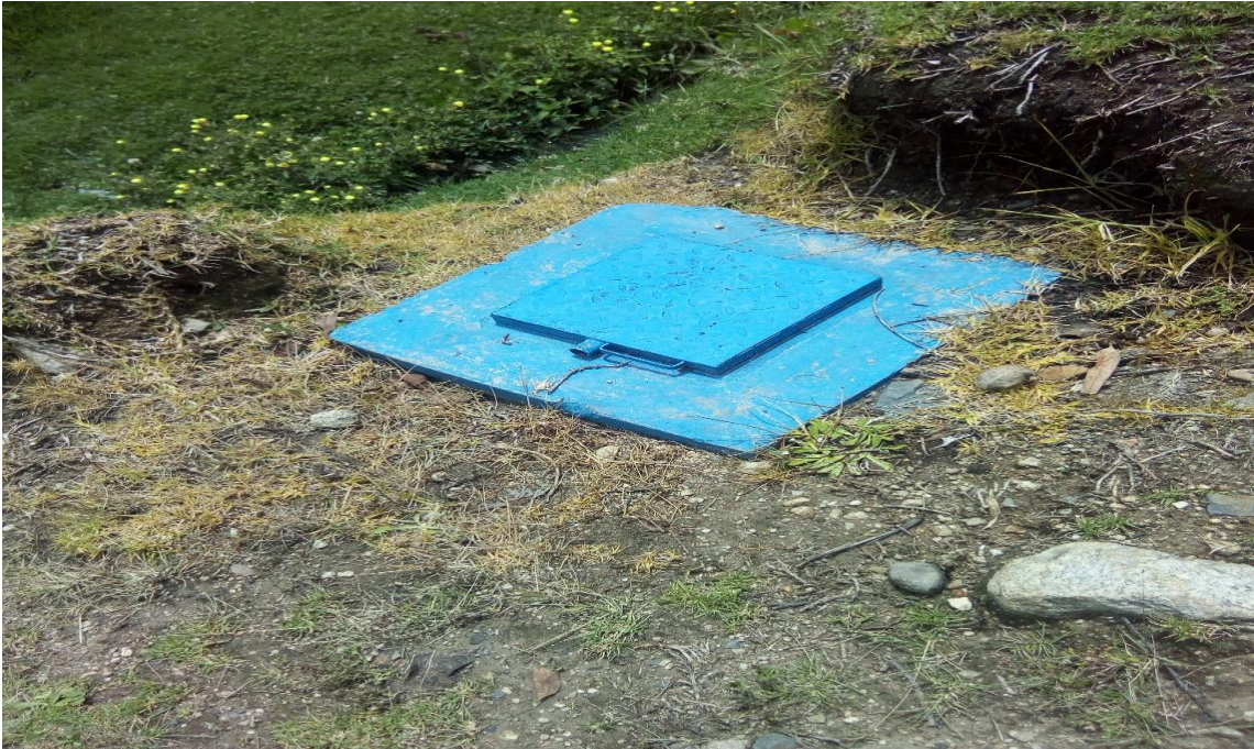
Figura 59. Visita de campo al sistema de saneamiento básico Fuente. Elaboración propia – 2020
