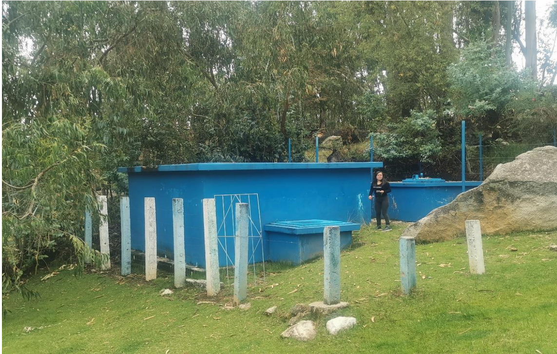
Figura 49. Visita de campo al sistema de saneamiento básico Fuente. Elaboración propia – 2020
