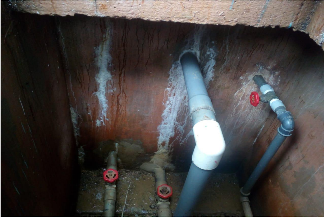
Figura 51. Visita de campo al sistema de saneamiento básico Fuente. Elaboración propia – 2020
