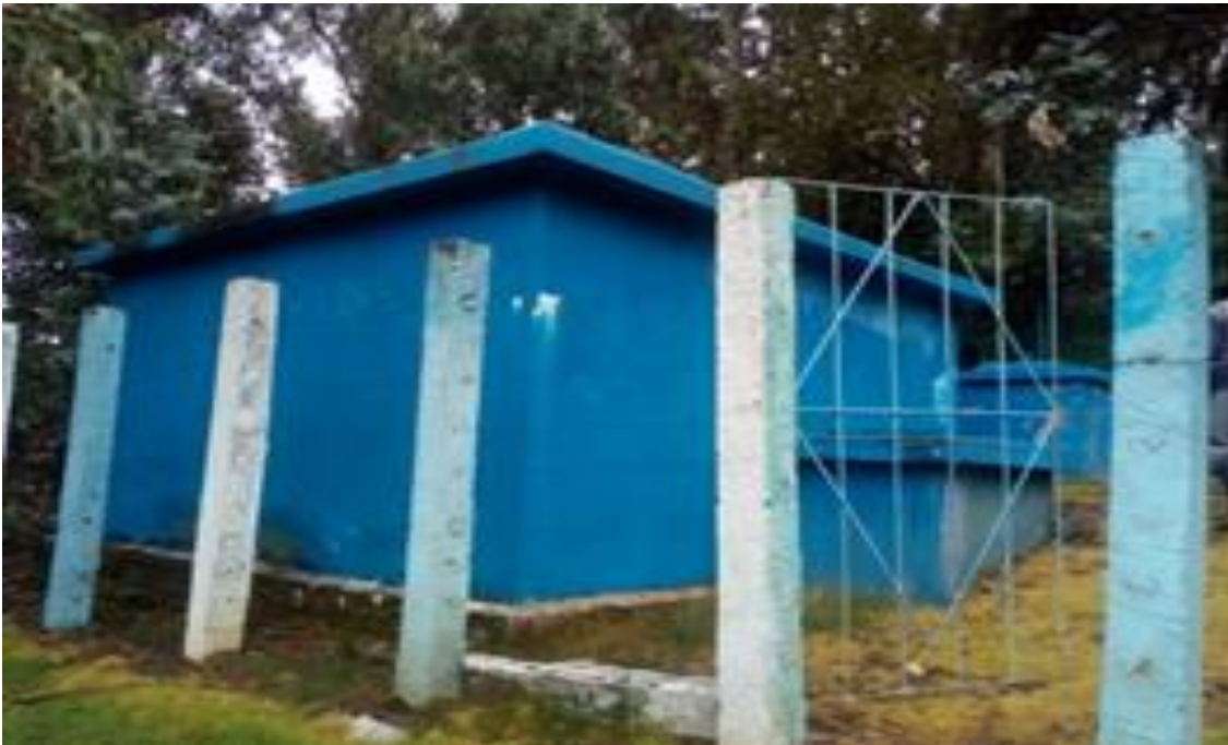
Figura 46. Reservorio 2 - Visita de campo al sistema de saneamiento básico Fuente. Elaboración propia – 2020
