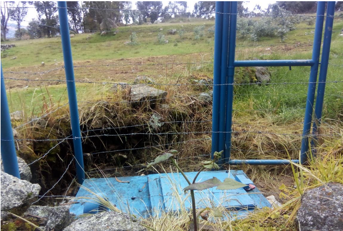
Figura 60. Visita de campo al sistema de saneamiento básico Fuente. Elaboración propia – 2020
