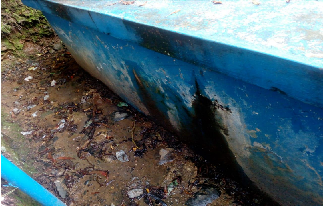
Figura 61. Reservorio - Visita de campo al sistema de saneamiento básico Fuente. Elaboración propia – 2020
