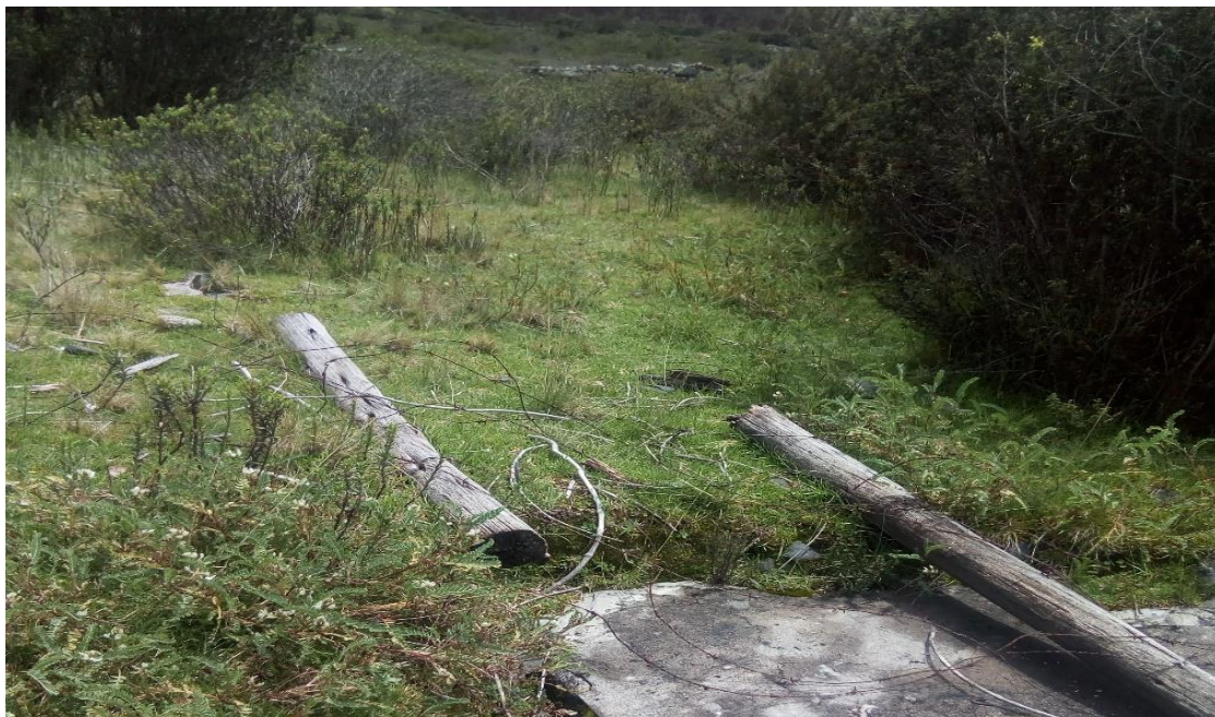
Figura 44. Línea de conducción - Visita de campo al sistema de saneamiento básico
