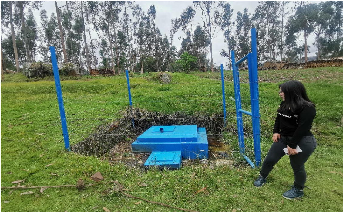
Figura 52. Visita de campo al sistema de saneamiento básico Fuente. Elaboración propia – 2020
