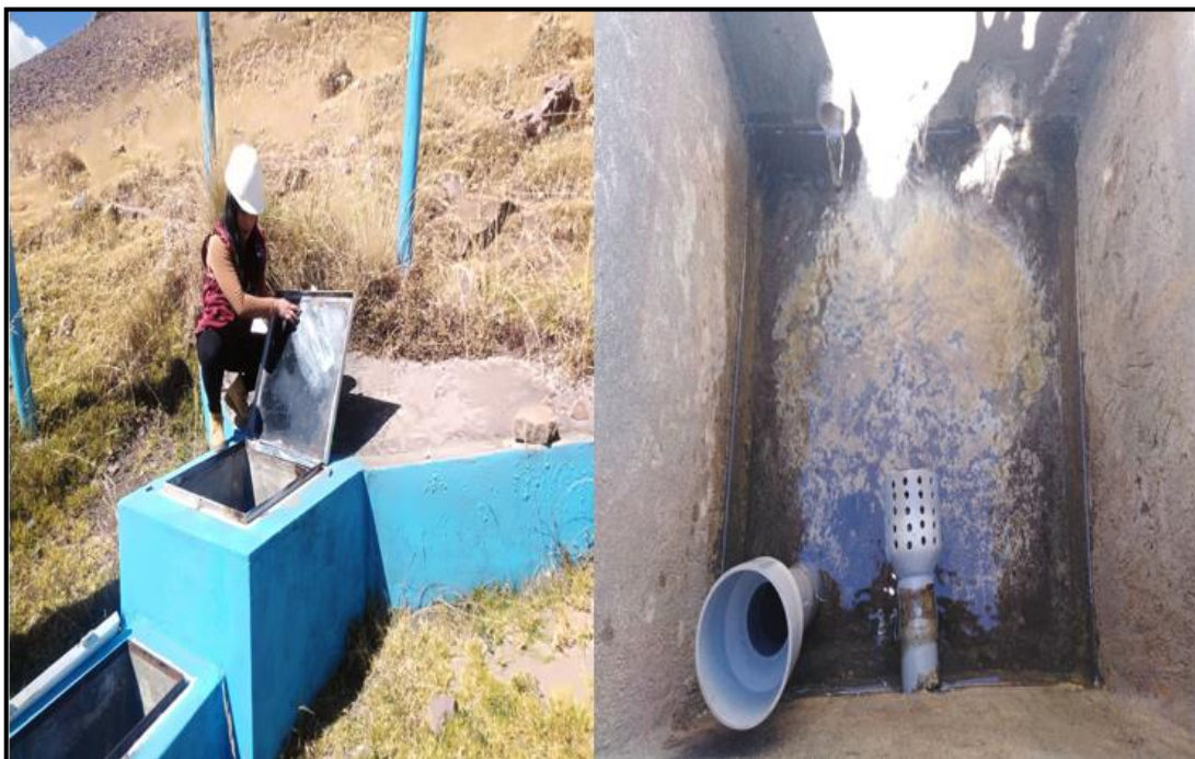
Fotografía 4. Presencia de fisuras (1), oxidación (2) y desprendimiento de tornillos (3) en la tapa de la captación.
