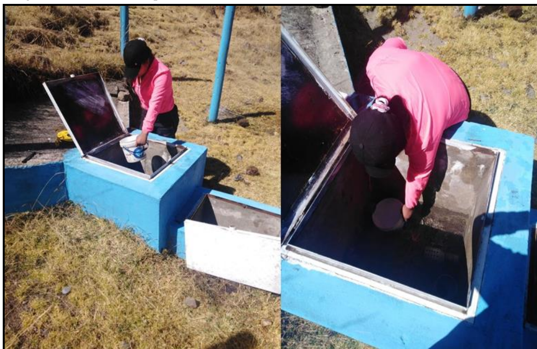
Fotografía 6.Aforo en la captación.
