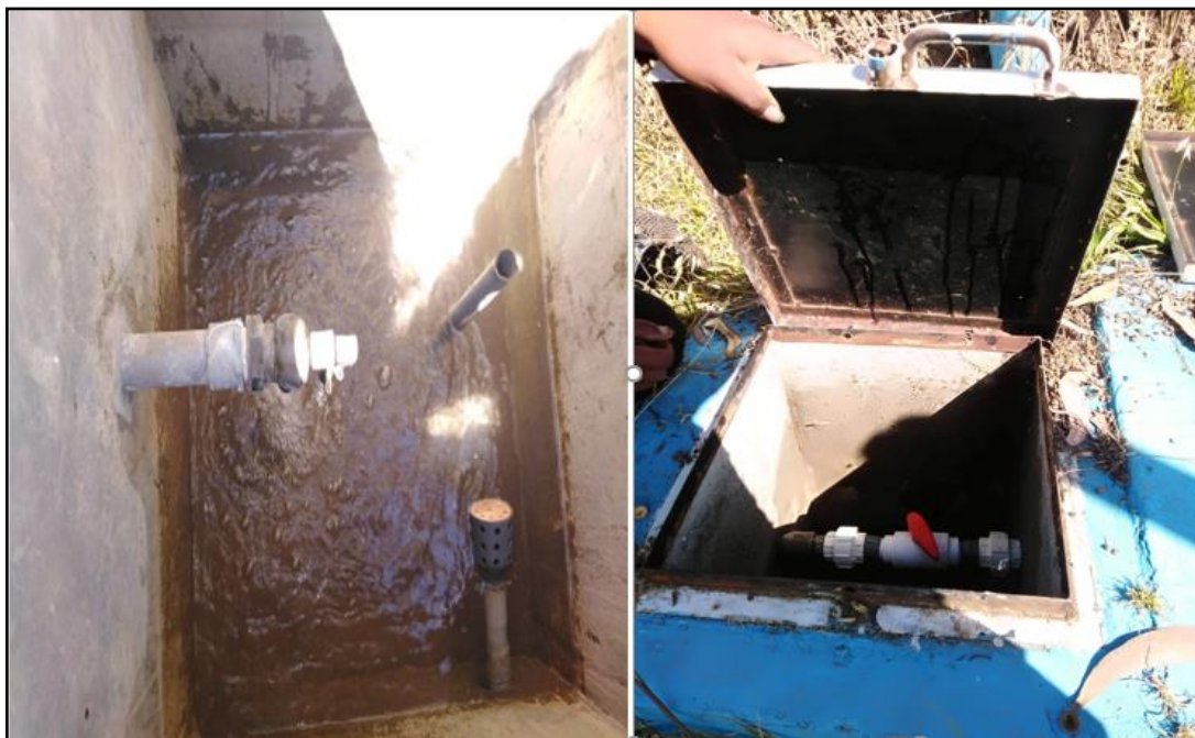
Fotografía 12. Desprendimiento de la tapa (1), oxidación (2) y (3) obstrucción de vegetales en cámara rompe presión T-7 y la caseta de válvulas.
