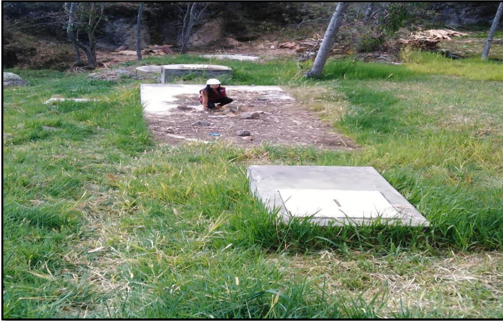
Fotografía 16. Visita a la planta de tratamiento de aguas residuales.
