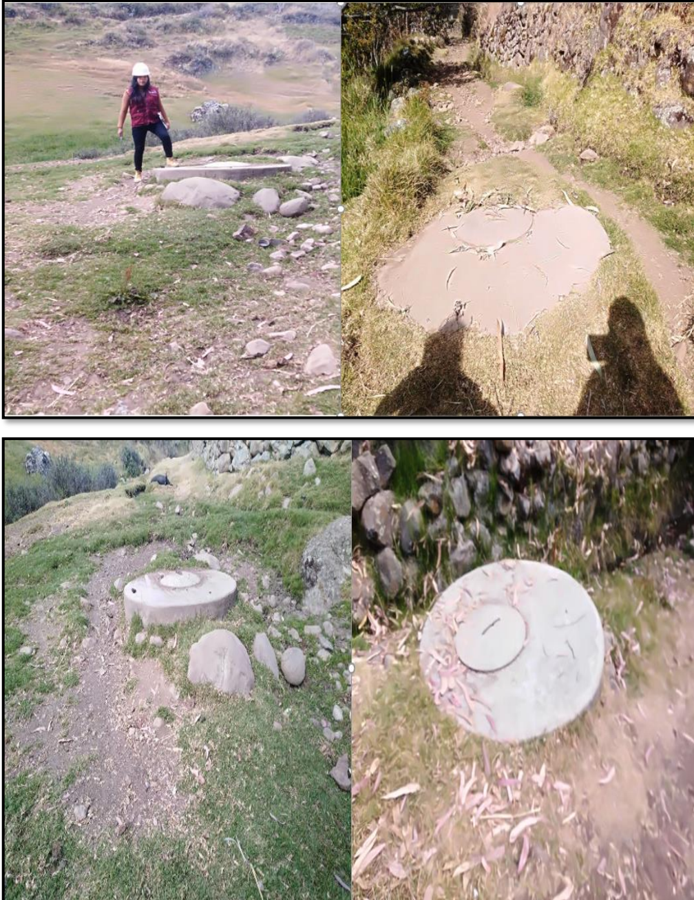
Fotografía 15. Buzones- sistema de desague.
