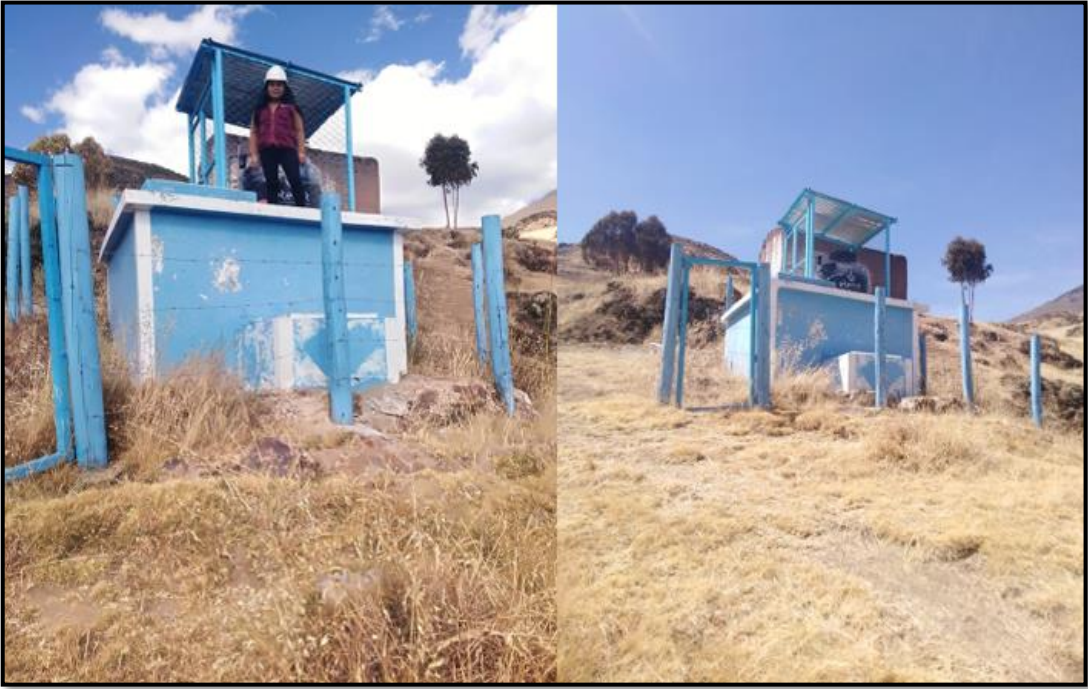
Fotografía 7. Visita al Reservorio y la caseta de válvulas.
