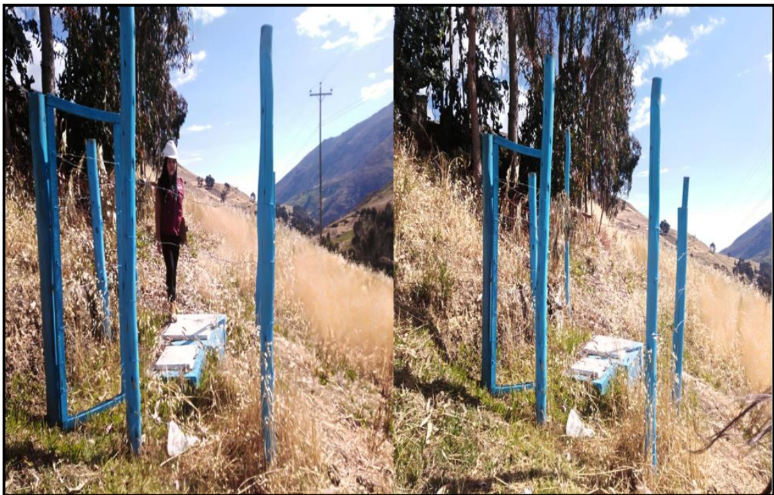
Fotografía 10. Visita al Cámara Rompe Presión T-7 y la caseta de válvulas.
