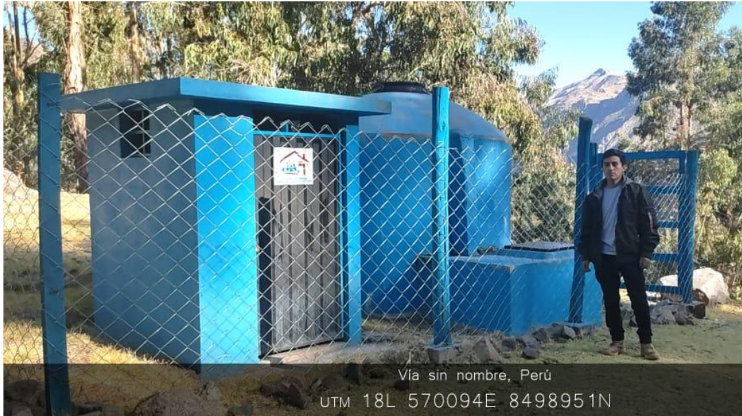
Figura 11: Visita a la captación Itana Waycco
