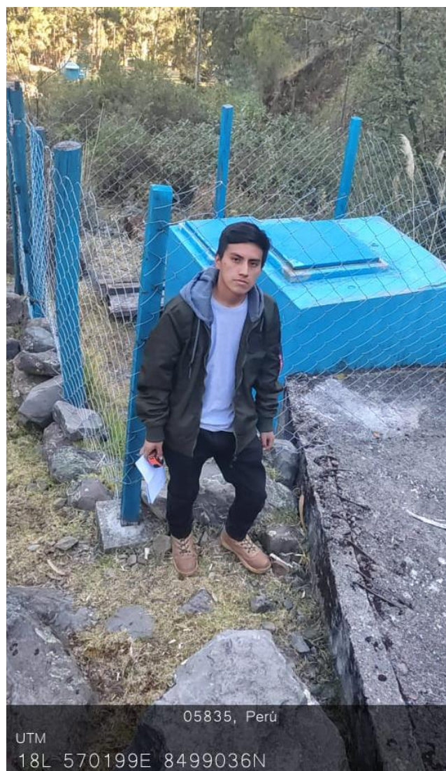
Figura 10: Visita a la captación Itana Waycco
