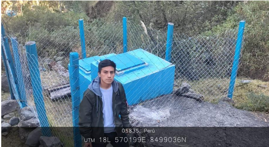
Fotografía 3: Visita a la captación del Sector Itana Waycco.
