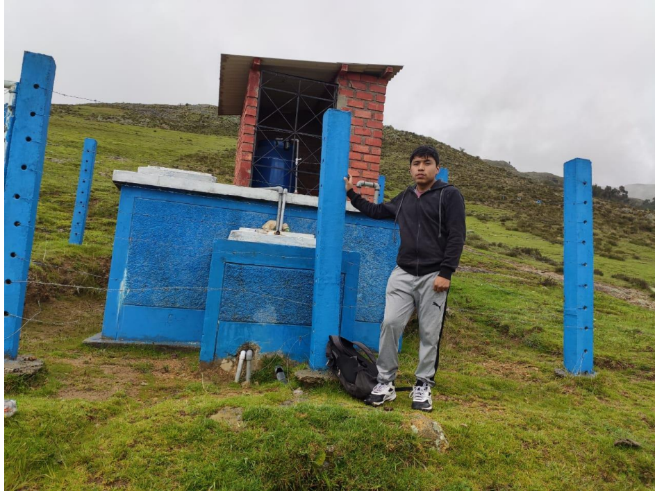
Fotografía N° 05: ALMACENAMIENTO Y SANEAMIENTO DEL AGUA DE YANAMITO
