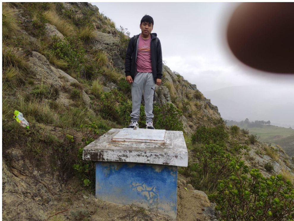
Fotografía N° 09: PRIMERA CAMA ROMPE PRESIÓN (CR-6)
