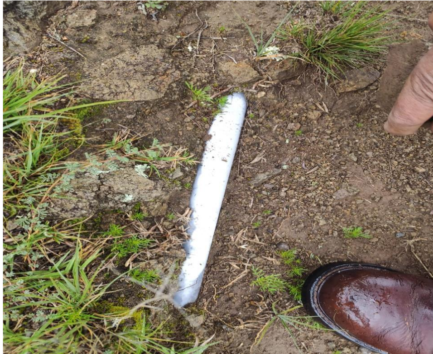
Fotografía N° 011: PARTES DE LAS VÍAS DE CONDUCCIÓN EXPUESTAS
