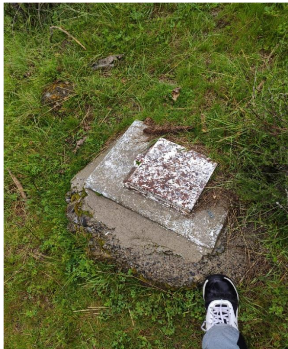
Fotografía N° 012: VÁLVULA DE AIRE
