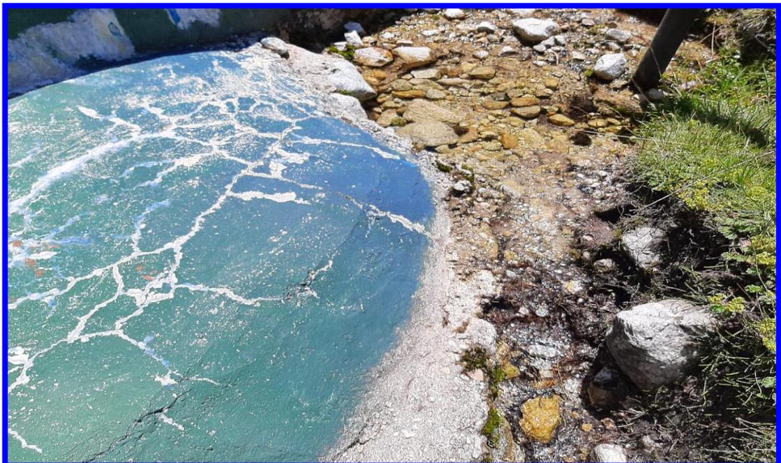
*Fotografía 2 Captación principal, concreto agrietado, y hay filtraciones en tiempo de lluvias.*
