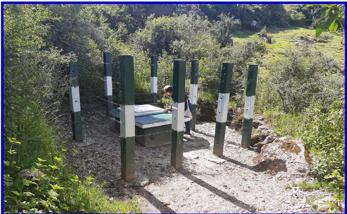
*Fotografía 6 1ra cámara de romper presión.*
