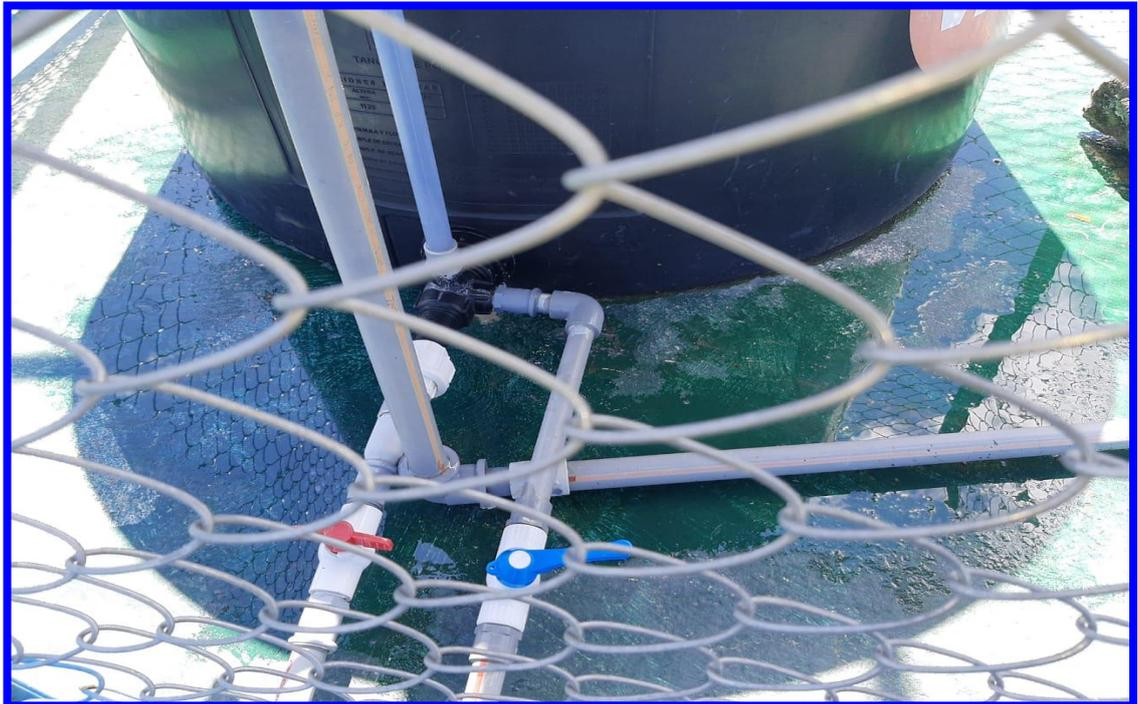
*Fotografía 5 Fugas de agua en el reservorio*
