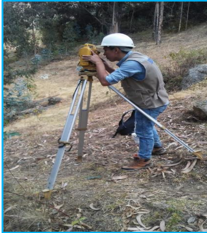
Figura 18: Levantamiento topográfico de la línea de conducción
