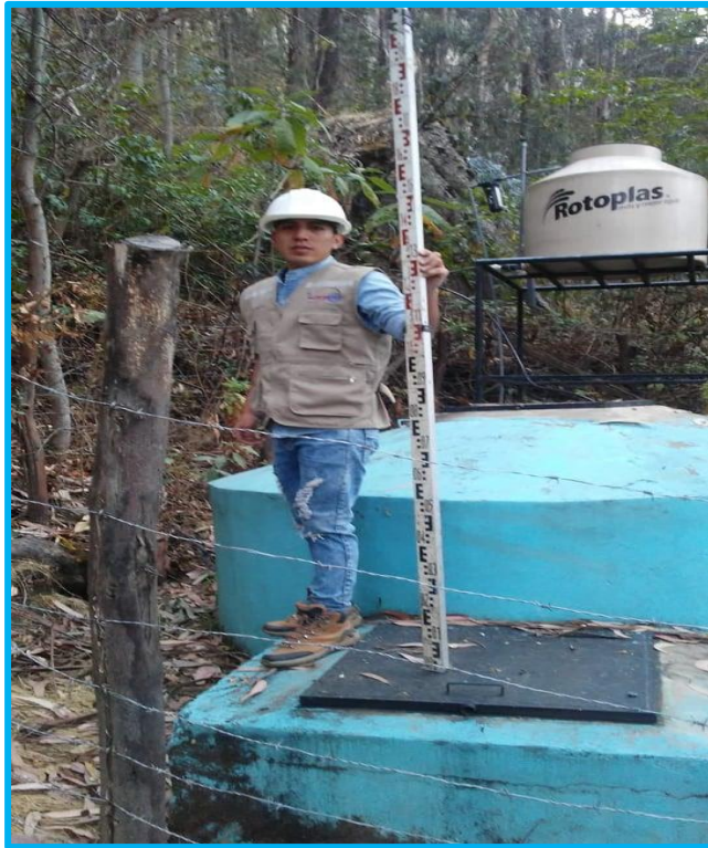
Figura 20: Se puede apreciar tomando puntos para determinar la altura de cota piezometrica del reservorio
