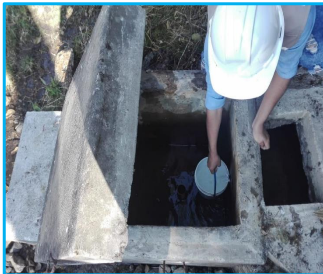
Figura 15: Vista del interior de la cámara húmeda
