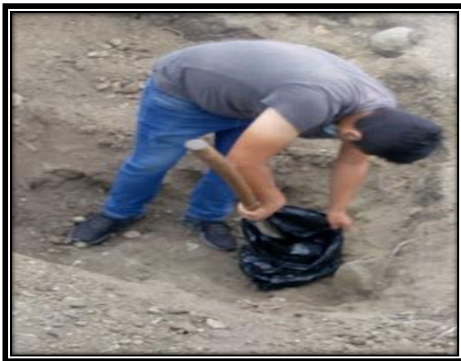
Fotografía 02: Excavación de calicata para su respectivo estudio de suelos.
