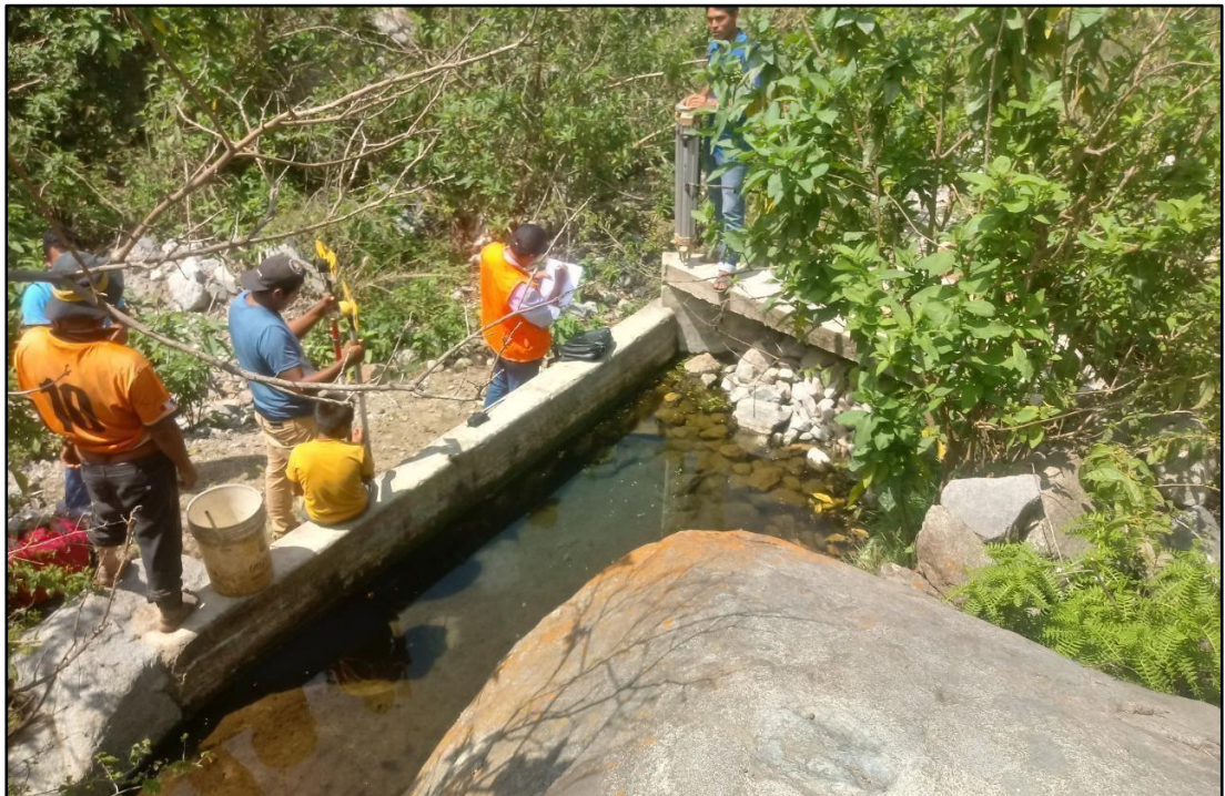
Imagen 2: Toma de puntos topográfico en la captación Mallqui
