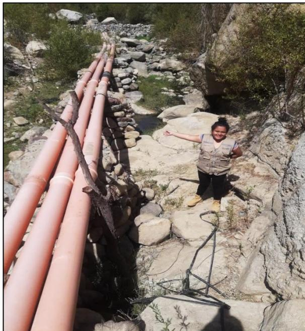
**Gráfico 52.** Línea de conducción a través de tuberías
