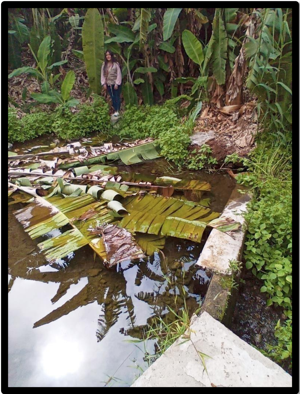
Fotografía 02: Captación de ladera – lado derecho
