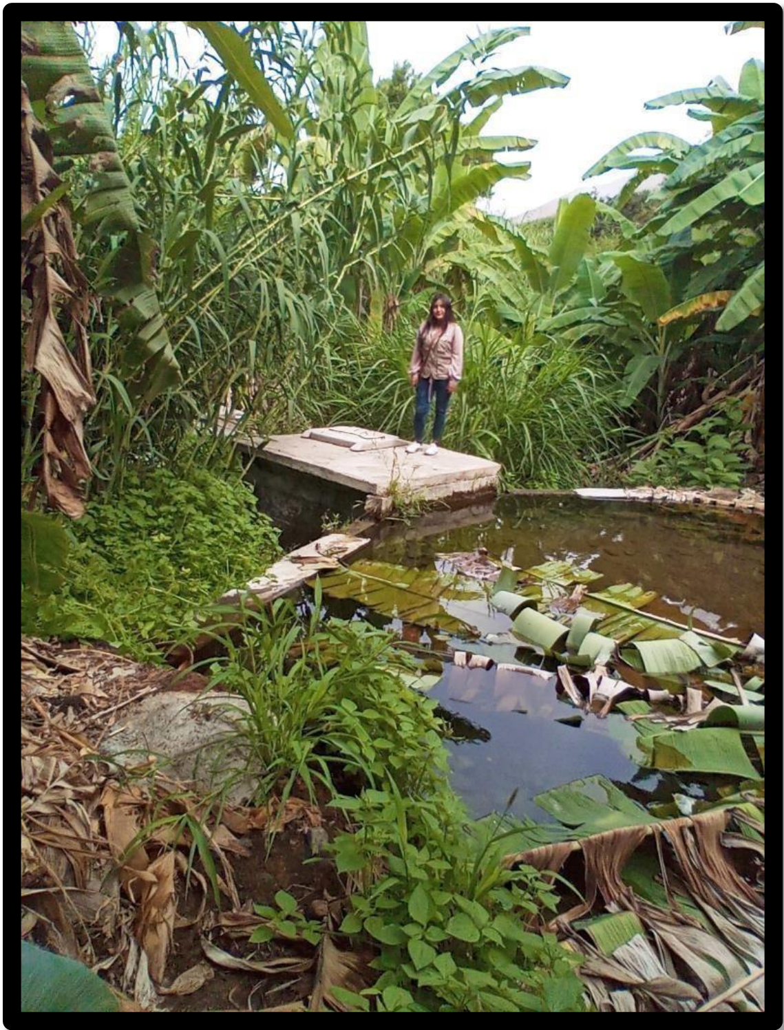
Fotografía 01: Captación de ladera
