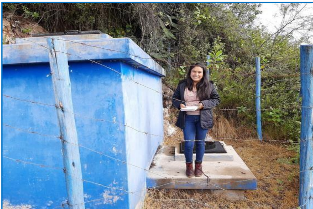
FOTOGRAFIA N° 2. VISITA AL RESERVORIO DEL SISTEMA DE AGUA DE COLLANA
