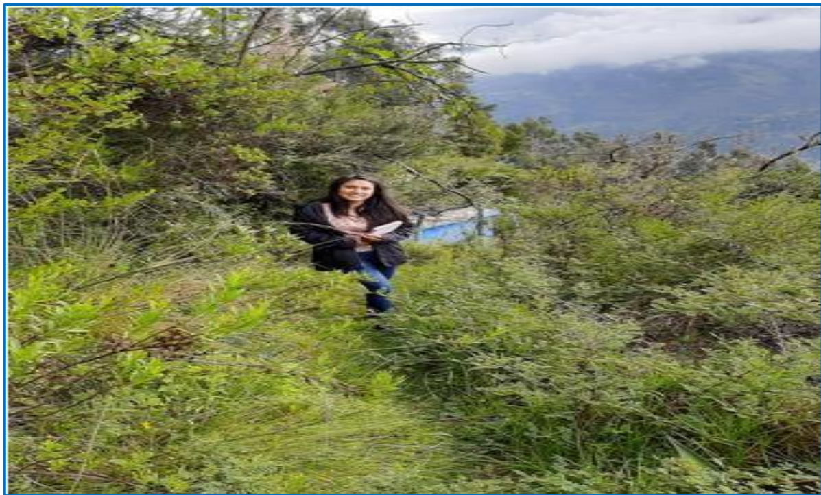
FOTOGRAFIA N° 6. VISTA DEL ACCESO LIMITADO A LAS ESTRUCTURAS A FALTA DE ACTIVIDADES DE MANTENIMIENTO DE LAS ESTRUCTURAS HIDRAULICAS.
