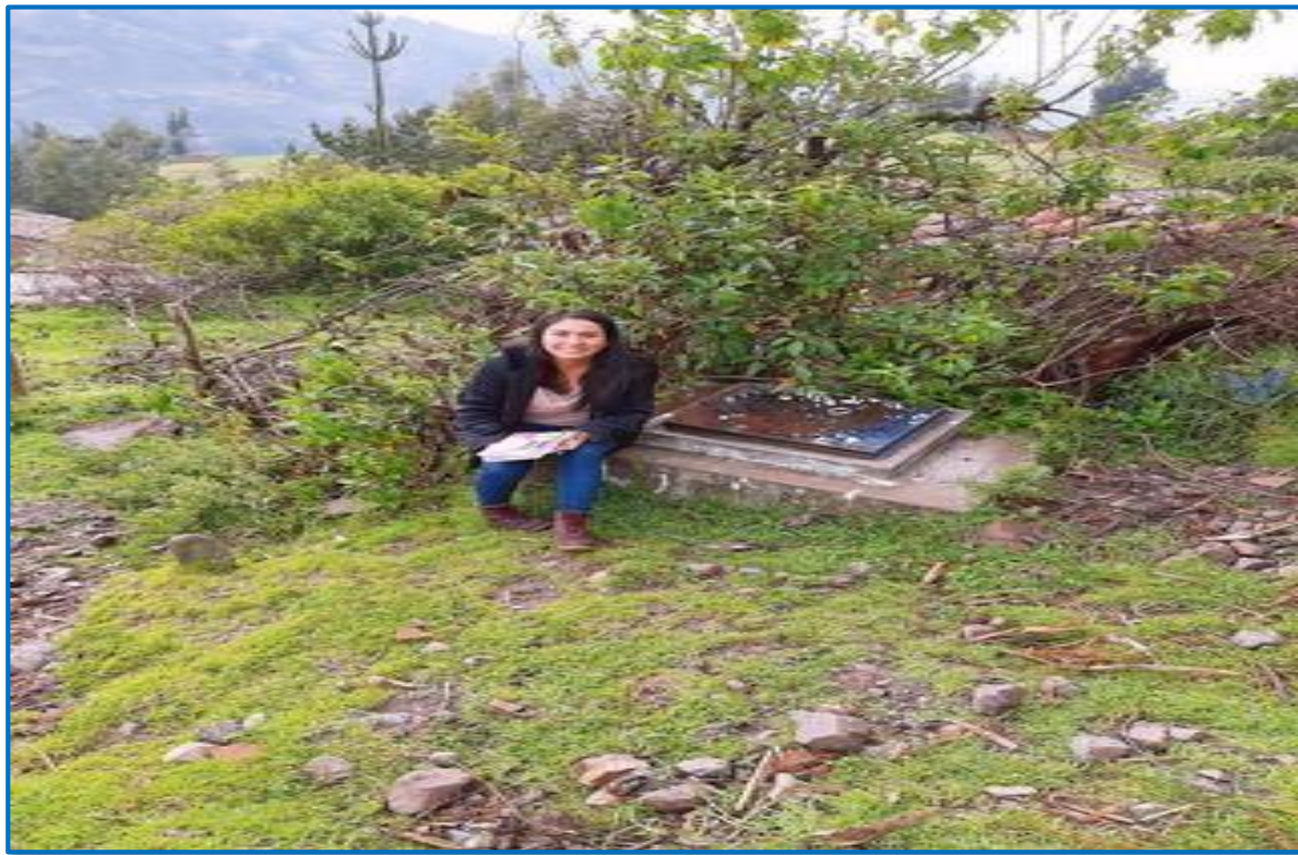
FOTOGRAFIA N° 5. OXIDACION VISIBLE EN LAS CAMARAS ROMPE PRESION.
