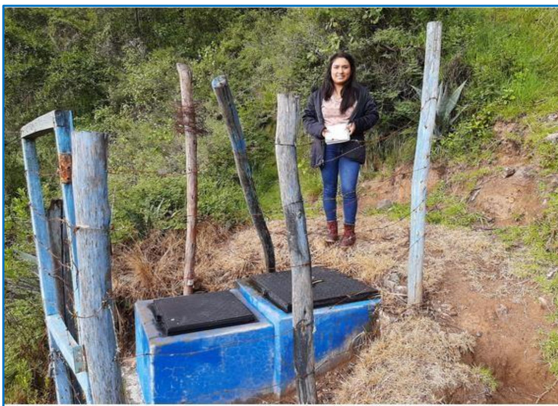
FOTOGRAFIA N° 1. DIAGNOSTICO DE LA CAMARA ROMPE PRESION DEL SISTEMA DE AGUA DE COLLANA
