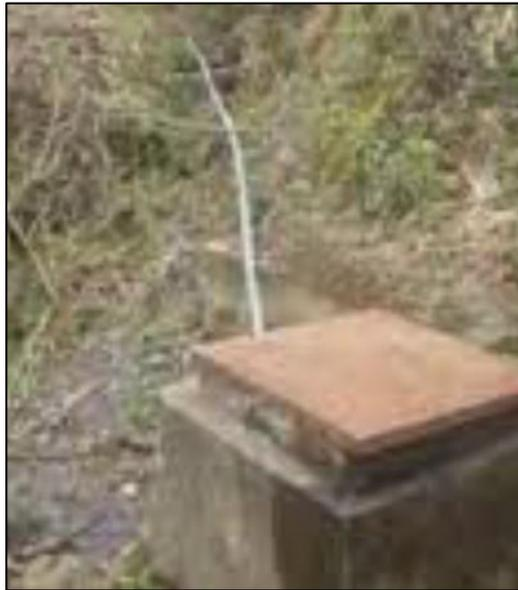
**Imagen 2** Línea de conducción expuesta al terreno y en mal estado
