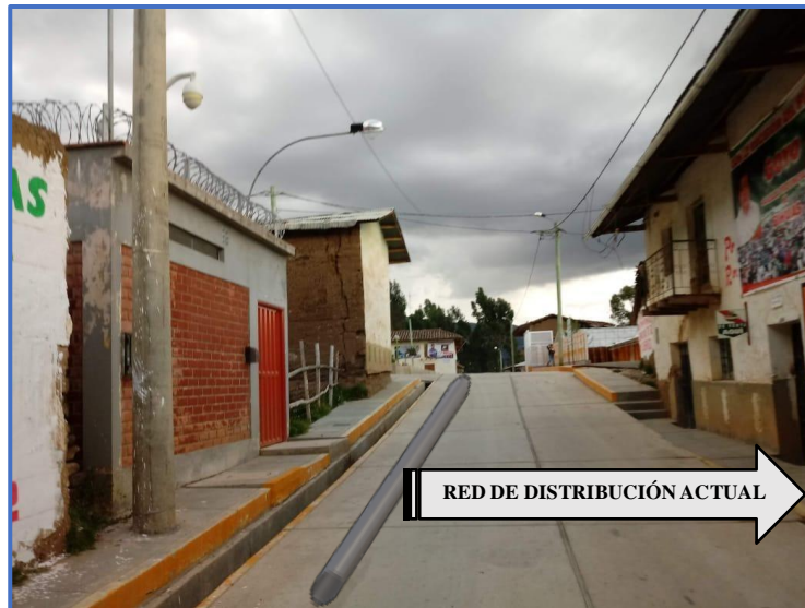
Figura 15: Estado de la línea de distribución.
