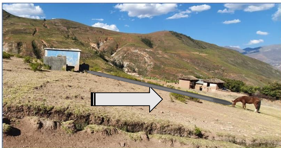
Figura 14: Estado de la línea de aducción.
