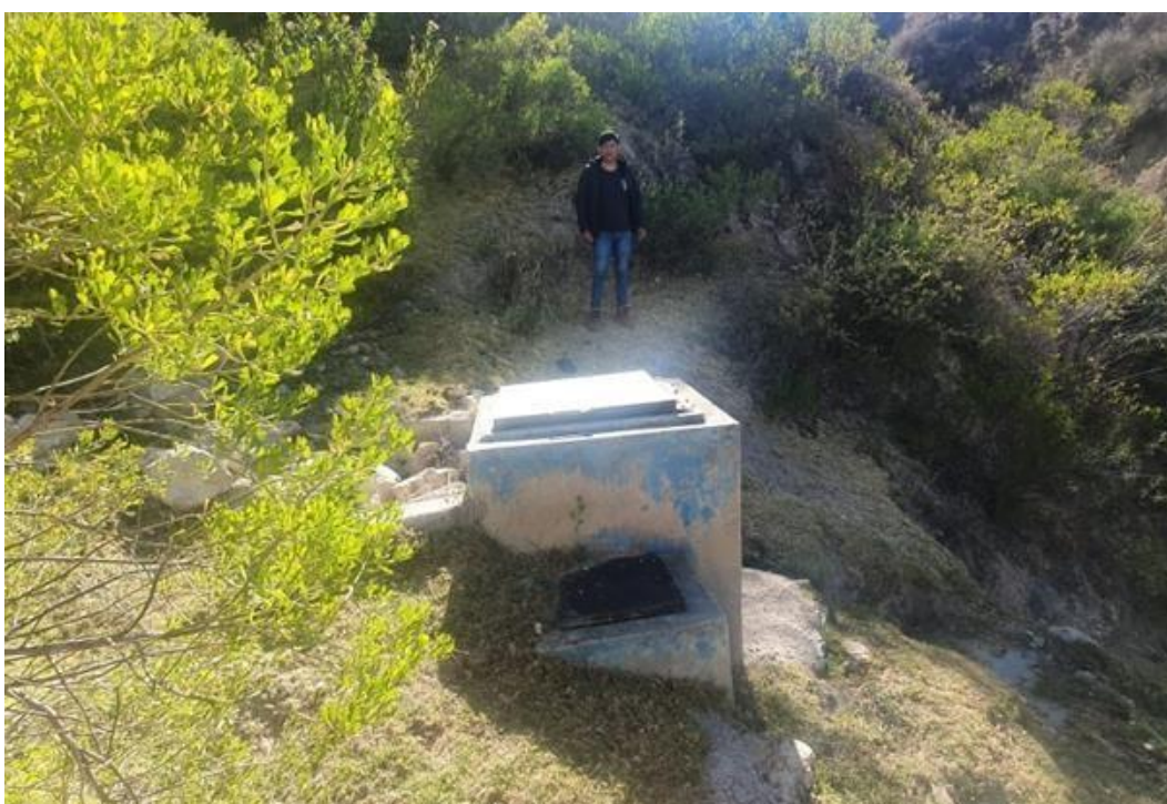
Imagen N° 02: Captación de manantial de ladera de la localidad de Cashapampa, Distrito de Cashapampa, Provincia de Sihuas, Departamento de Áncash – 2022.
