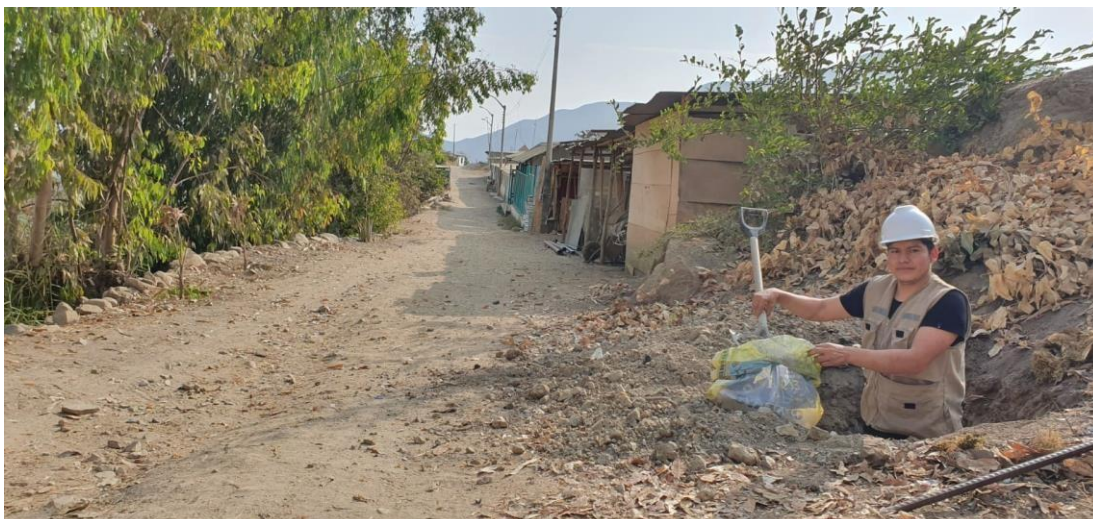
Imagen N° 05: Realización de la calicata en la localidad de Cashapampa, Distrito de Cashapampa, Provincia de Sihuas, Departamento de Áncash – 2022.
