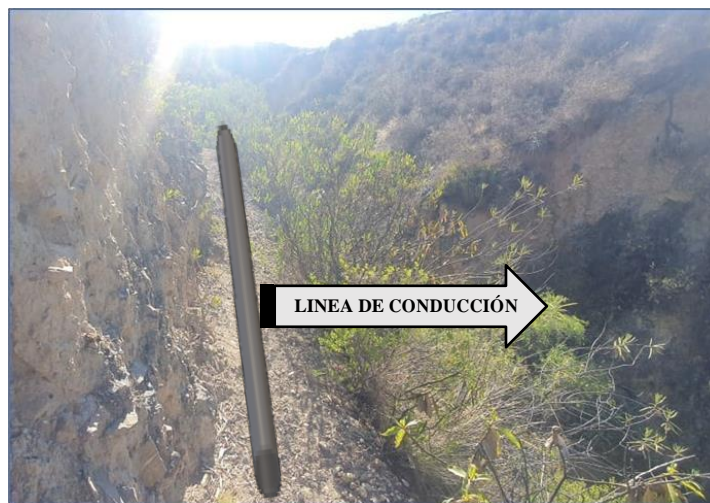
Figura 12: Estado de la línea de conducción.
