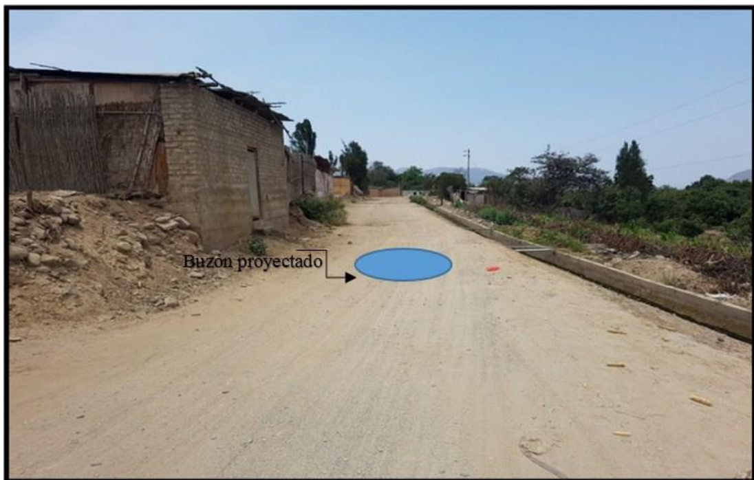
Imagen 6. Área destinada para el inicio de la red de alcantarillado, Buzón N° 6
