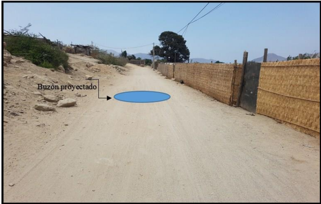
Imagen 5. Área destinada para el inicio de la red de alcantarillado, Buzón N° 5
