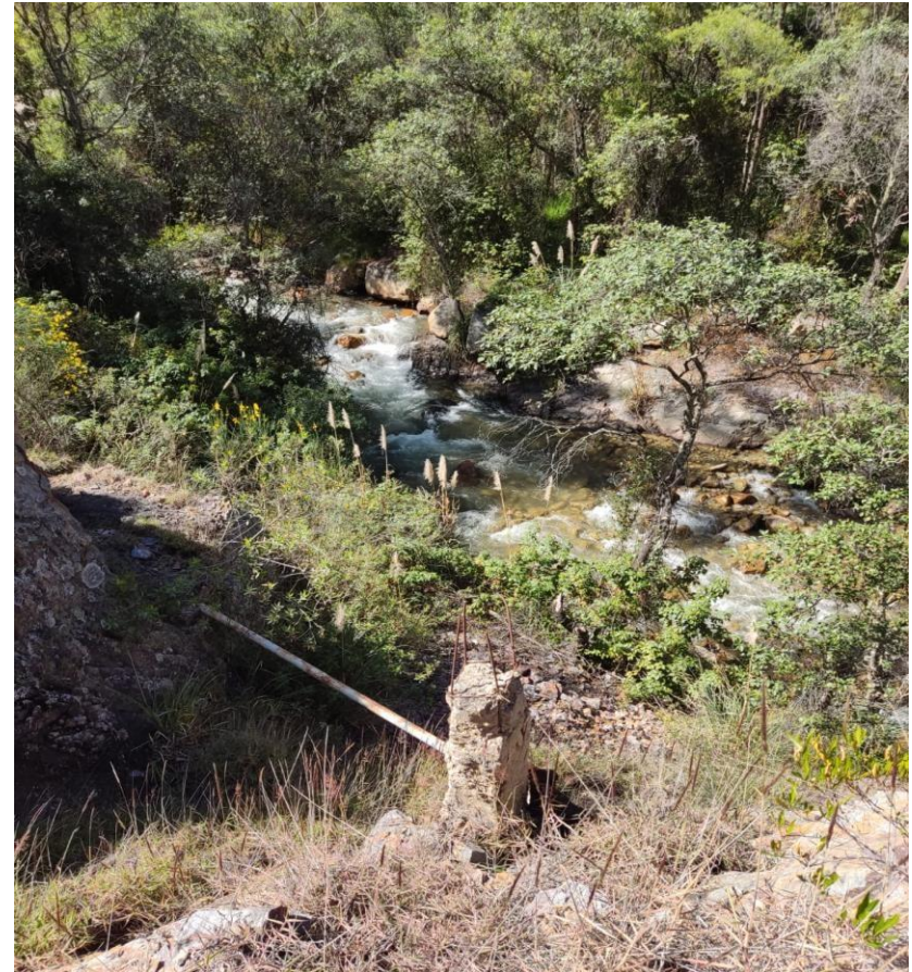
Imagen 3 Línea de Conducción
