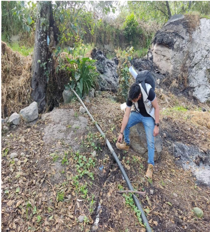
Imagen 2 Línea de Conducción
