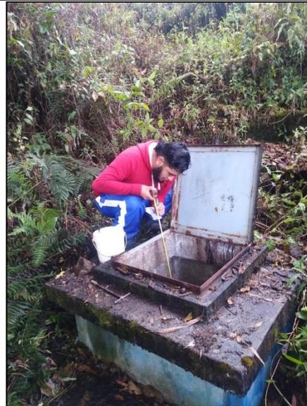
Fotografías N°05 y 06: Cámara húmeda de la Captación del sistema de agua potable
