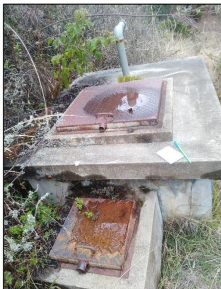
Fotografía N°20: Buzón de la Red de Alcantarillado Sanitario
