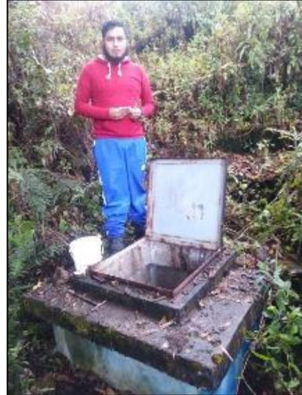
Fotografías N°11 y 12: Línea de Conducción – Cámara Rompe Presión
