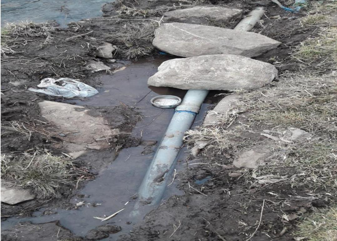
**Imagen 26:** fotografía se puede observar la tubería empalmada y sigue expuesto al ambiente.
