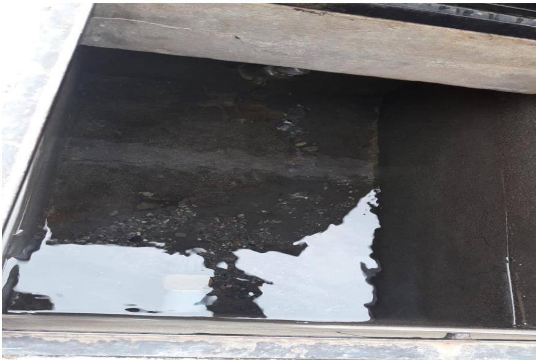
**Imagen 30:** fotografía de evaluación de la cámara de rompe presión tipo 7.
