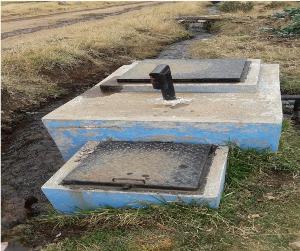
**Imagen 29:** fotografía de la cámara de rompe presión tipo 7.
