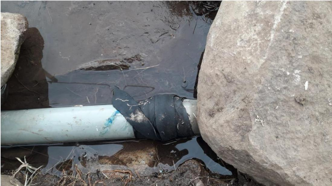
**Imagen 27:** fotografía se observa tuberías envueltas con jebe y aplastados con piedras.
