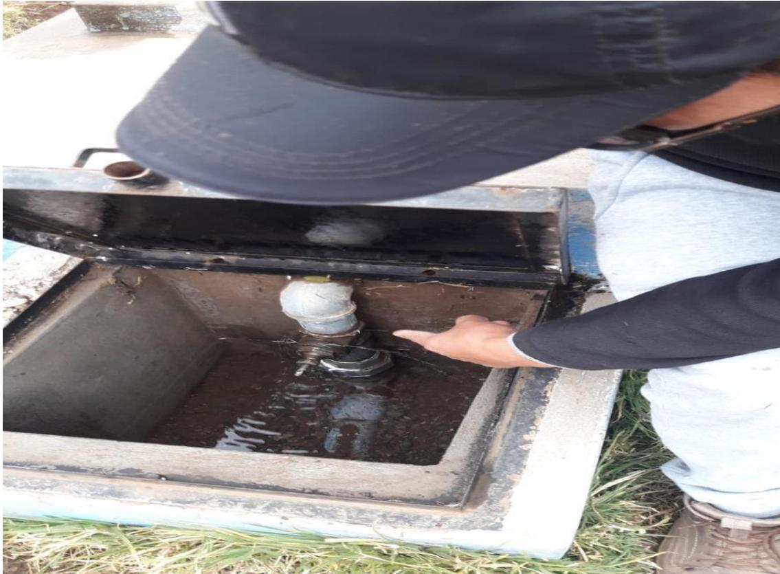
**Imagen 32:** fotografía de la válvula control carece de manija y hay filtración de la cámara de rompe presión tipo 7.
