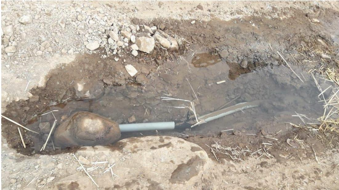
**Imagen 28:** fotografía se observa fuga de agua a pesar de estar envueltas con jebe.
