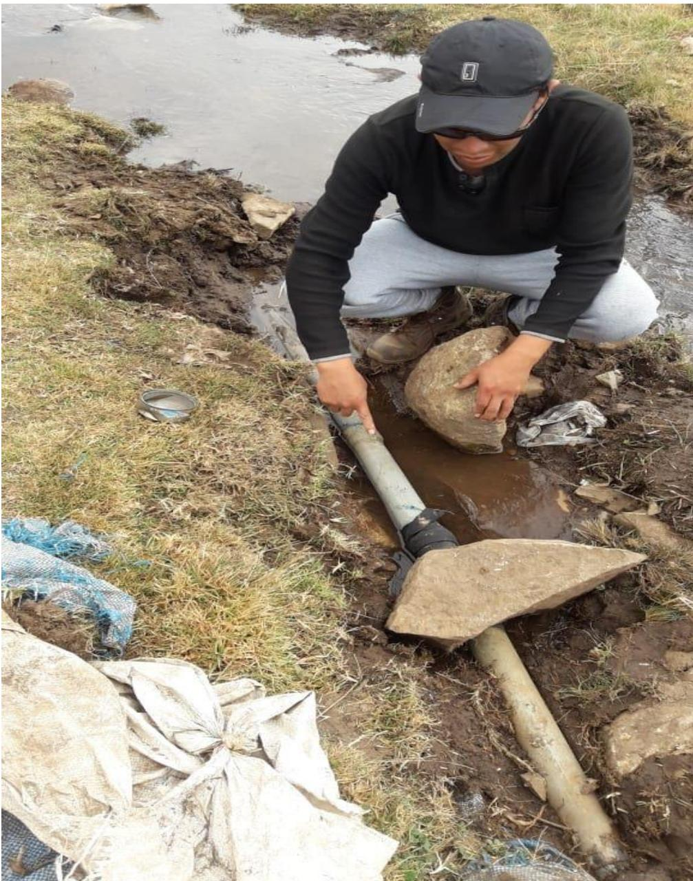
**Imagen 25:** fotografía donde se observa las tuberías con fuga de agua han sido envuelto con jebes.
