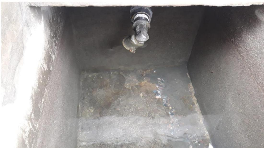
**Imagen 31:** fotografía del interior de la cámara de rompe presión tipo 7.
