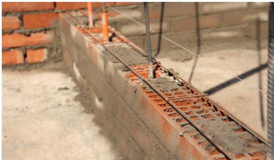
Figura 02. Imagen de albañilería armada
