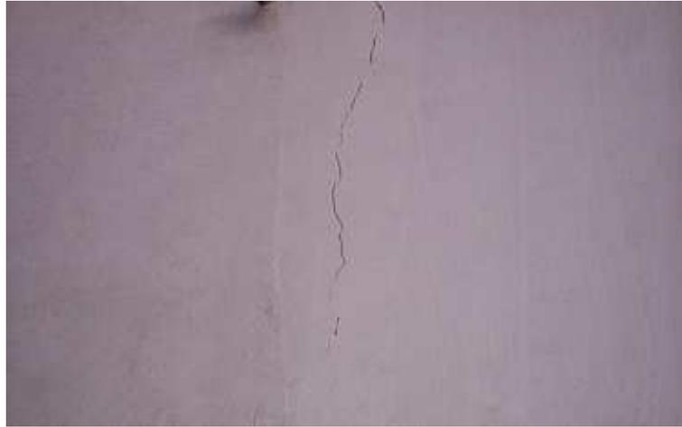
Figura 10. Imagen de fisura en muro.
