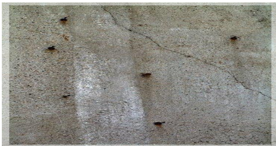
Figura 11. Fisura
