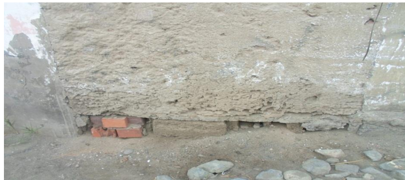
Figura 14. Disgregación
