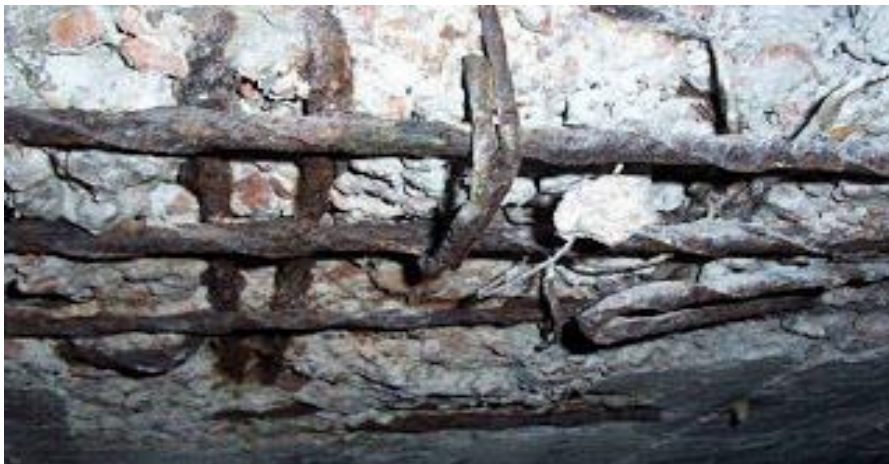
Figura 15. Corrosión
