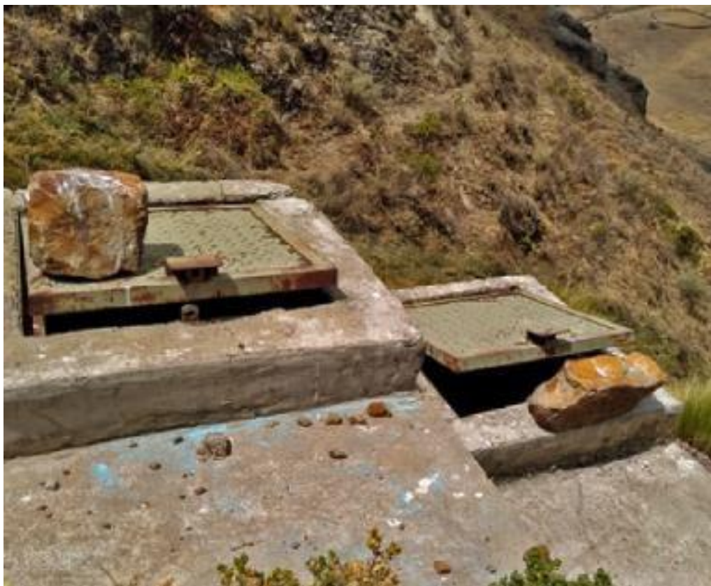
Imagen 1. Captación artesanal del caserío Tunin
