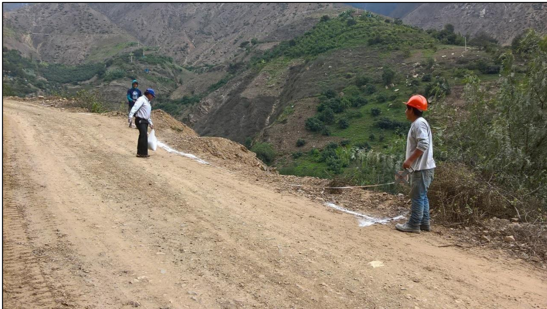
Imagen 15. Se realizaba el trazo y la suma de la línea de conducción
