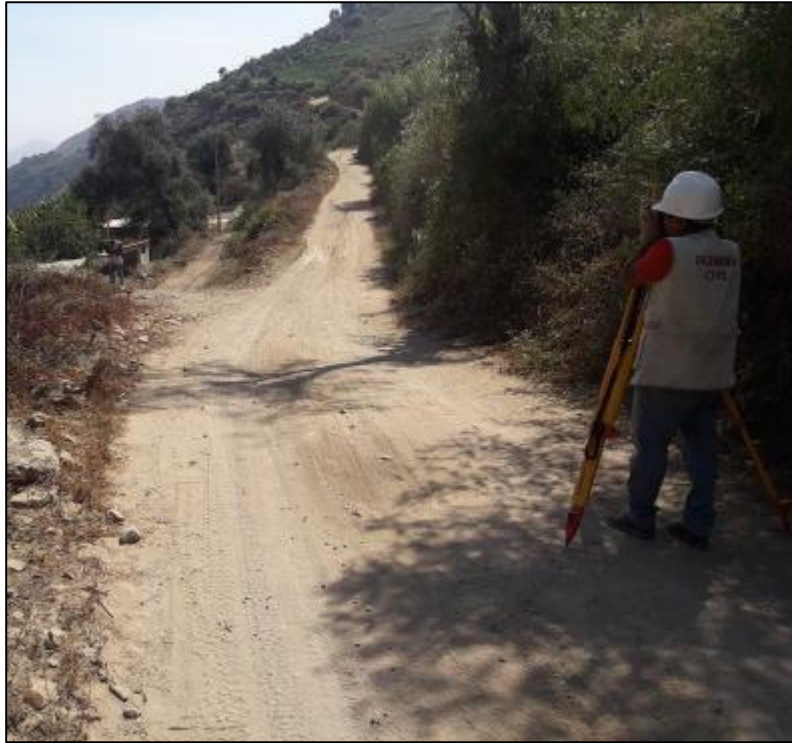
Imagen 18. Acá podemos observar que se está tomando los puntos topográficos de la línea de conducción.
