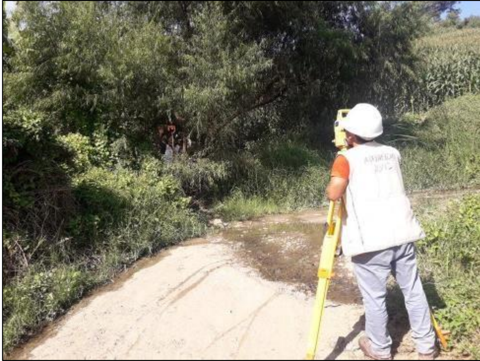
Imagen 16. Acá podemos observar que se está tomando el punto topográfico de la captación de manantial.
