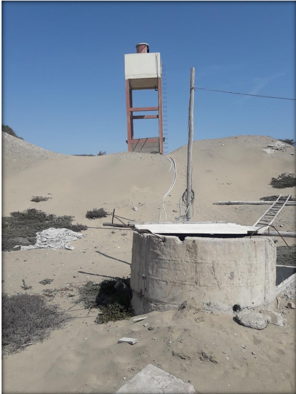
Fotografía 02: Toma panorámica de captación, línea de impulsión y reservorio del centro poblado el Hornito
