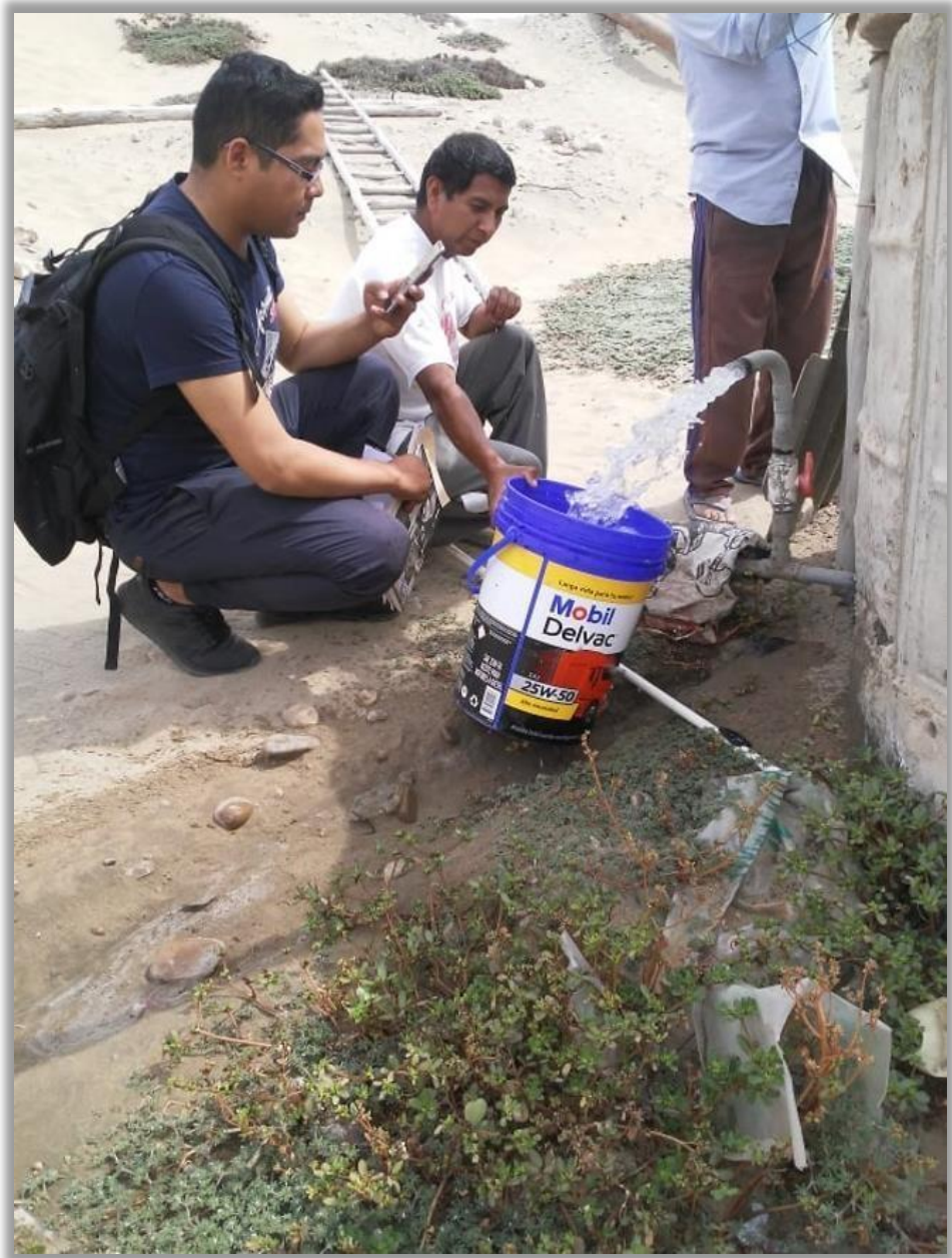
Fotografía 04: Determinación de caudal, por el método volumétrico, para la línea de impulsión.
