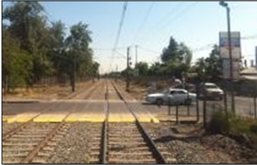
Figura 2.26: Cruce de vía férrea.
