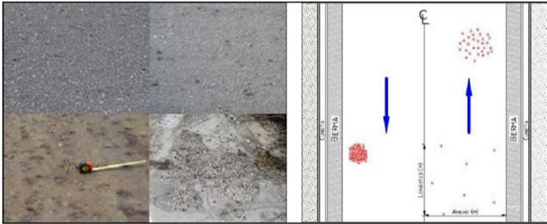
Figura 2.21: Desprendimiento de agregados. Fuente:(Manual de pavimentos flexibles (2006)).
